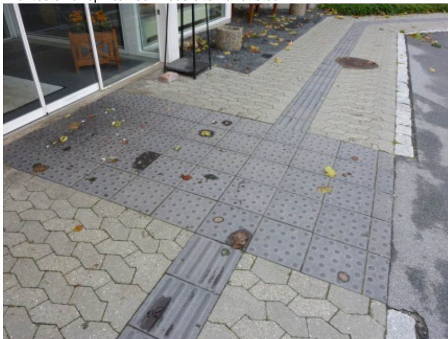
Figur 31: Opmærksomhedsfelt foran indgangsdør, ca. 2,4 x 1,5 m
