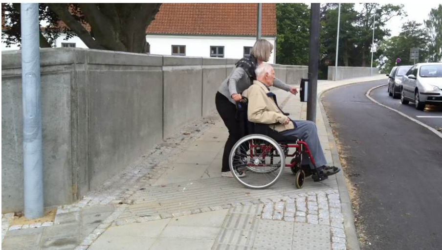
Figur 47: Høj kant betyder omvej for kørestolsbrugere og rollatorbrugere for at betjene tvungent fodgængertryk
