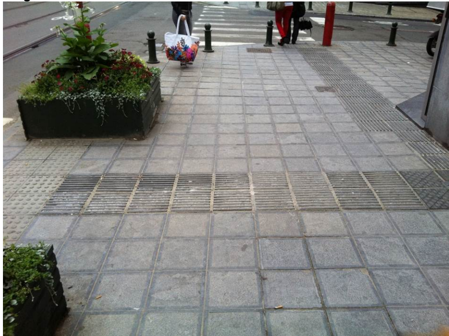
Figur 9: Overgang med 0-kant, Bruxelles.
