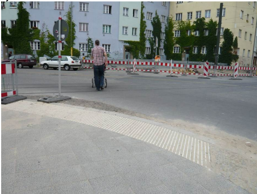
Figur 11: Retningsorienterende opmærksomhedsfelt med kontrast og 2,5 cm kant, under anlæg, Berlin
