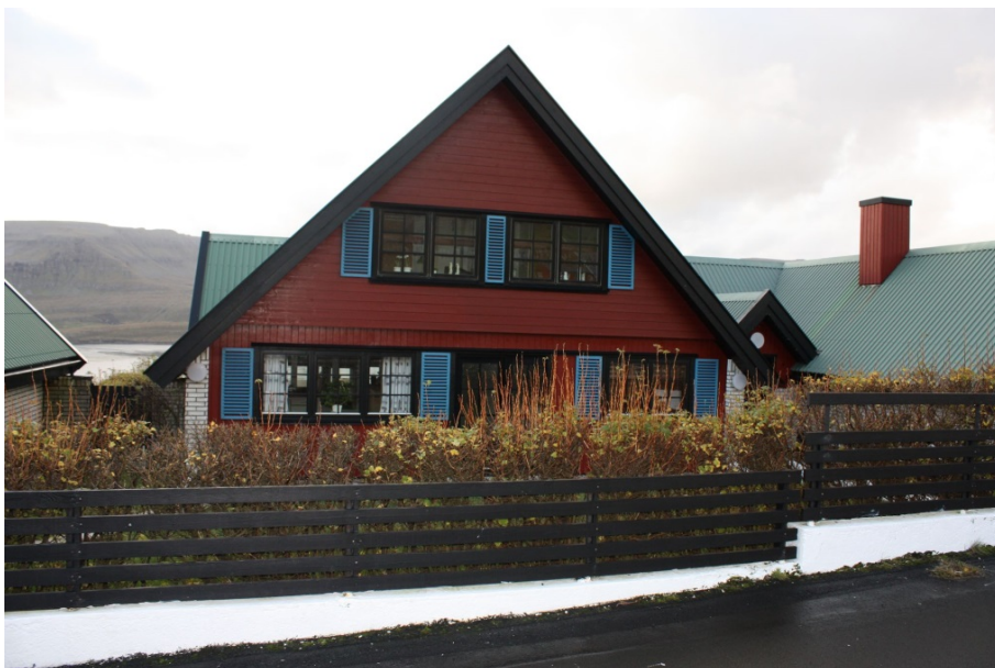
Figur 12. Parcelhus på Suðuroy set fra vej.
