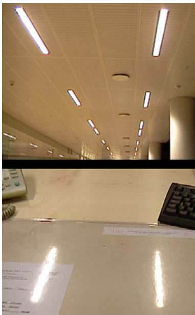
Spejlinger og reflekser fra loftsarmaturerne i de blanke og gennemsigtige skriveunderlag.
