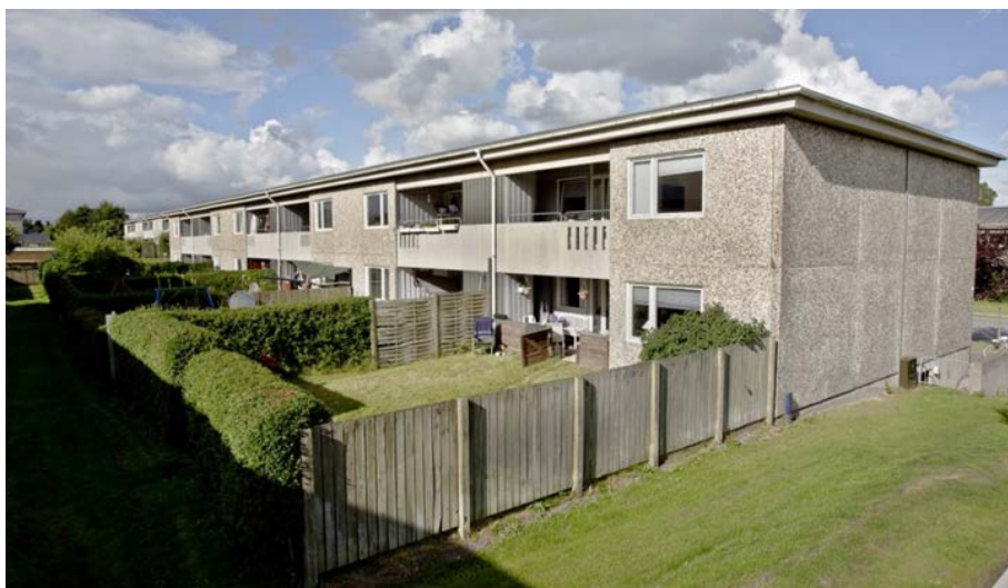
Fyrkildevej i Aalborg Øst før renoveringen.
