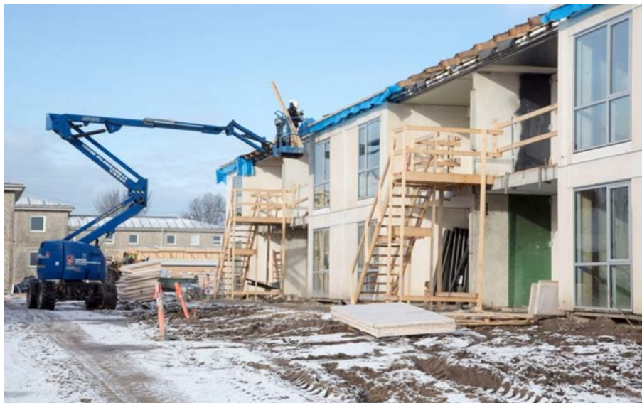
Renovering af Kildeparken, Blåkildevej, 2014
