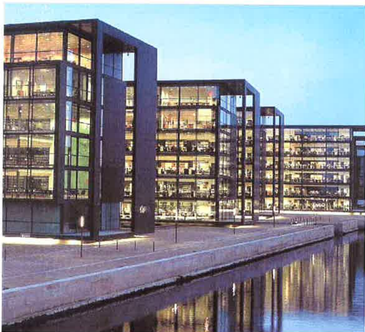
Figur 4.2: Nordeas domicil, nordfacaderne.
