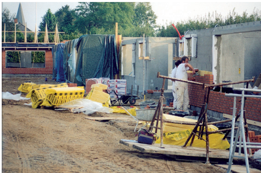
Figur 9. Murersjakket arbejdede med skalmuring på et rækkehusbyggeri i Sønderjylland, og de var to svende, en arbejdsmand og en lærling. Der var ikke andre fag og kun deres skurvogn på pladsen.
