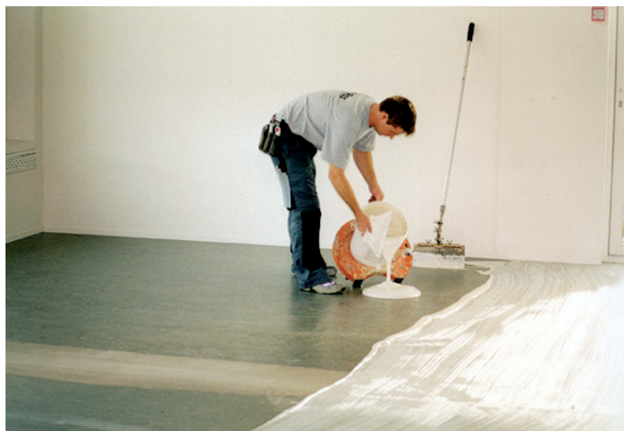
Figur 15. Den udviklede kørende limspand på 'toiletbrættet' i aktion, og limen er klar til fordeling med 'spartelsvaberen'. Efter en time var de 150 m 2 tæppegulv lagt, og rummet kunne tages i brug.
