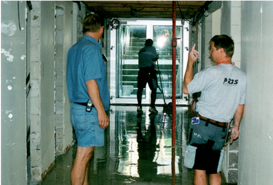
Figur 12. Gulvsjakket var meget fleksibelt, og det gav fx ingen problemer for en vvs-montør, da de skulle efterspartle et nyspartlet gulv, fordi han blev nødt til at gå hen over det.
