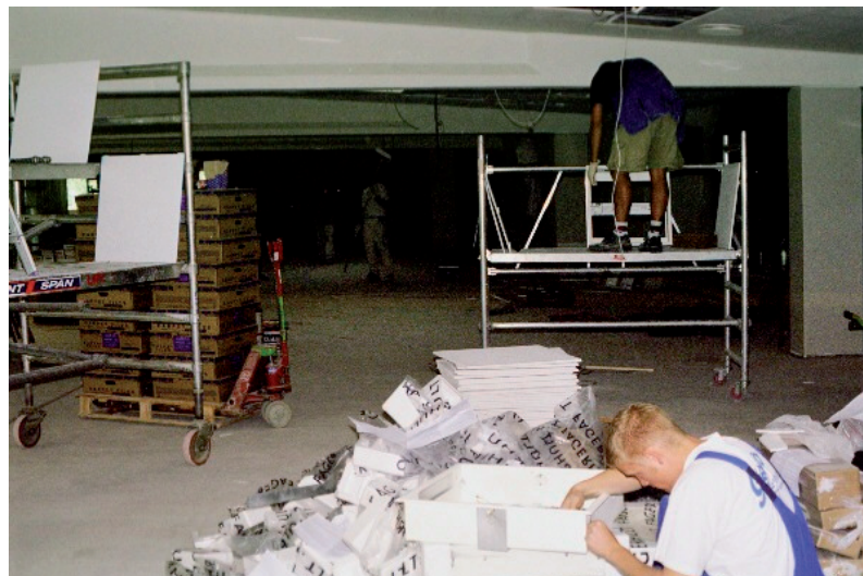
Figur 7. Malersjakket arbejdede på en stor totalombygning samtidig mellem elektrikere og vvs-installatører, og de skulle arbejde mellem dynger af byggematerialer og stilladser.
