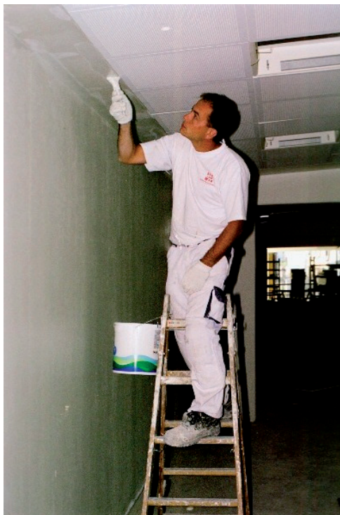
Figur 8. Loftkanterne blev malet fra stige, og malersvendene gik på deres stiger over byggematerialer med håndværkere og rådgivere vimsende omkring.
