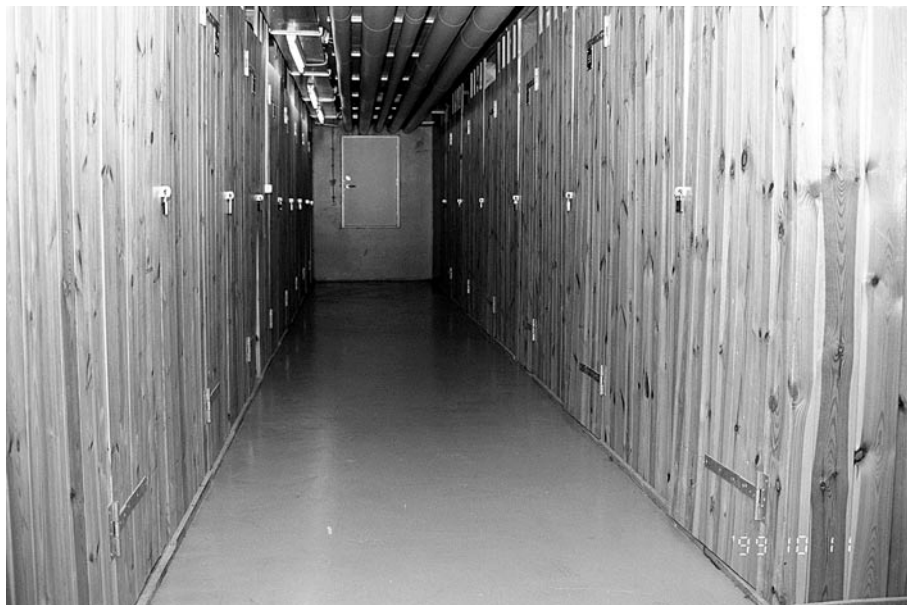
Figur 7. Private kælderrum af høj kvalitet. Malet gulv og vægge og lukkede trædøre.
