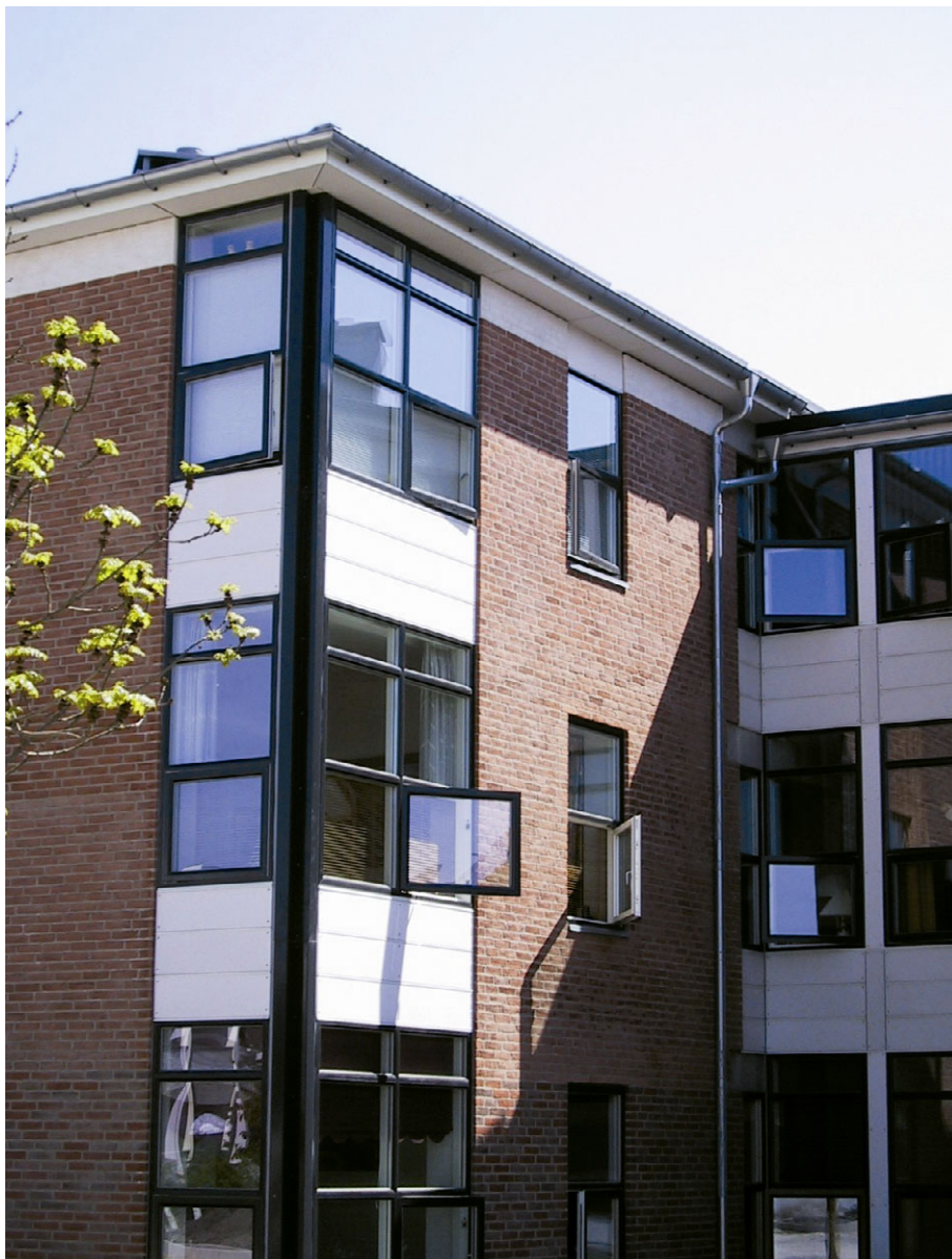
Figur 21. Udvendig facade, murværk og plade.
