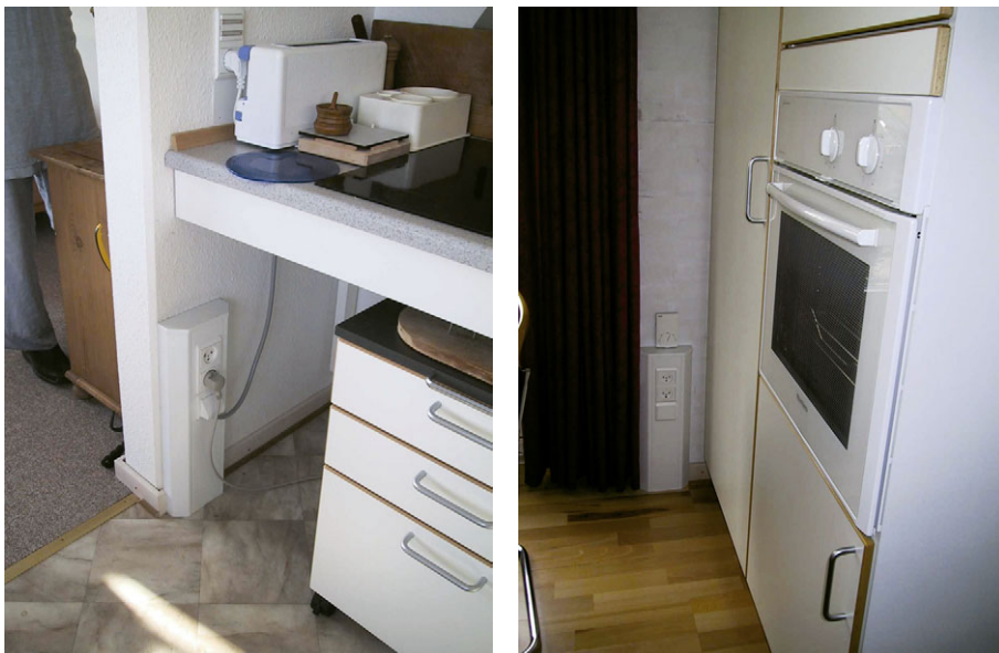
Figur 27. Billedet tv. viser en elstander er anbragt på den knebne plads under køkkenbordet. Billedet th. viser, at ovnlågen er anbragt i bordhøjde, men er bundhængslet.
