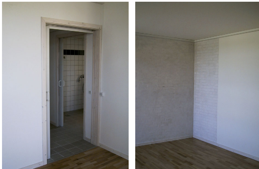
Figur 22. Billedet tv. viser overgangen mellem gulvmaterialer i henholdsvis stue, entre og badeværelse. Billedet th. viser overgangen mellem murværk og gipsvæg i stuen.
