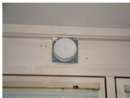
Figur 8. Fugtstyret udeluftventil fabr. Aereco type EHT 5-40. Ventilens udvendige mål er ca. 14 x 24 cm.
