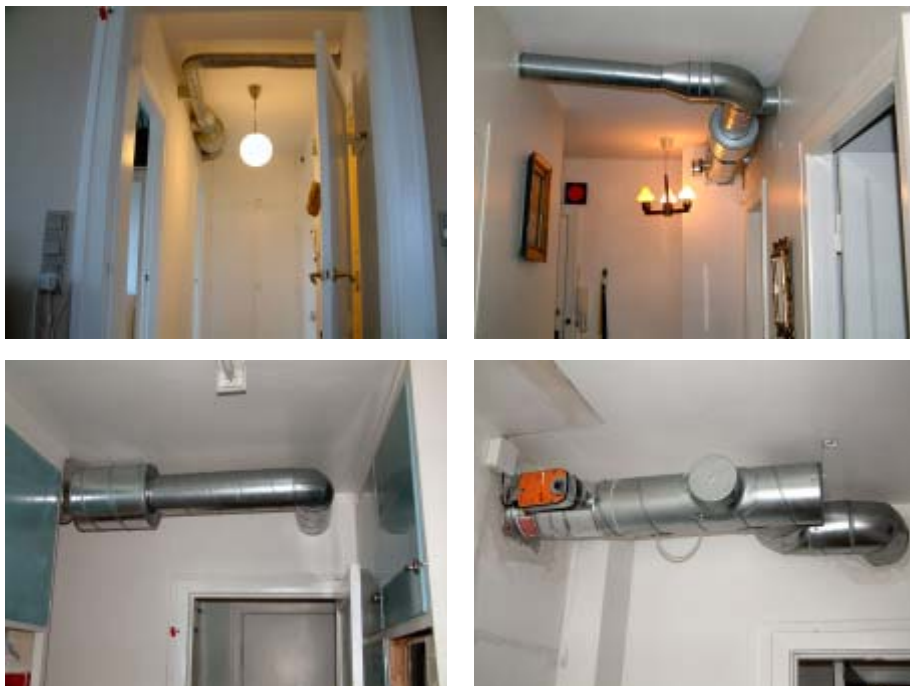
Figur 31. Eksempler på kanalføring i forsøgslejlighederne.
