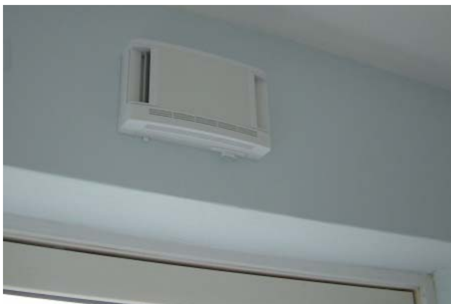
Figur 8. Fugtstyret udeluftventil fabr. Aereco type EHT 5-40. Ventilens udvendige mål er ca. 14 x 24 cm.
