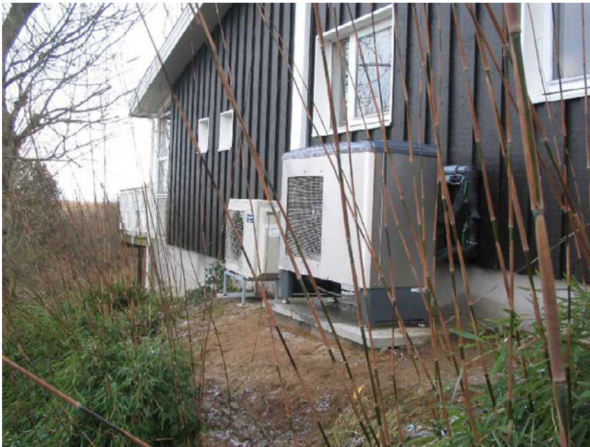
Figur 12. Varmepumper har den fordel, at de leverer mellem 3 og 5 gange den mængde energi i form af varme, de forbruger i el (foto Ellehauge).
