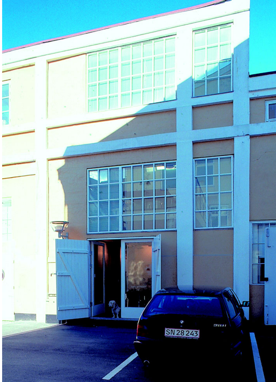
Indgangspartiet og facaden med vinduer.
