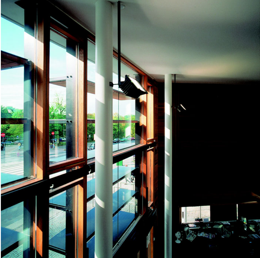
Foyeren med udvendige, faste lameller mod syd.
