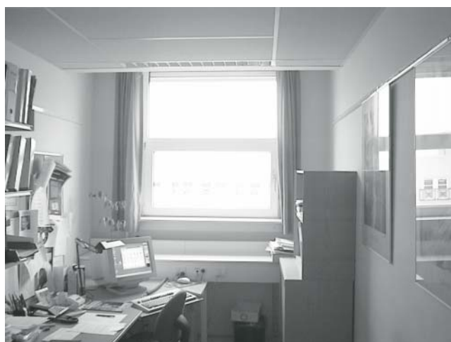
Vestvendt kontor på ét modul. Kontoret har meget højsiddende vinduer på grund af den høje brystning og det hævede loft ved facaden.
