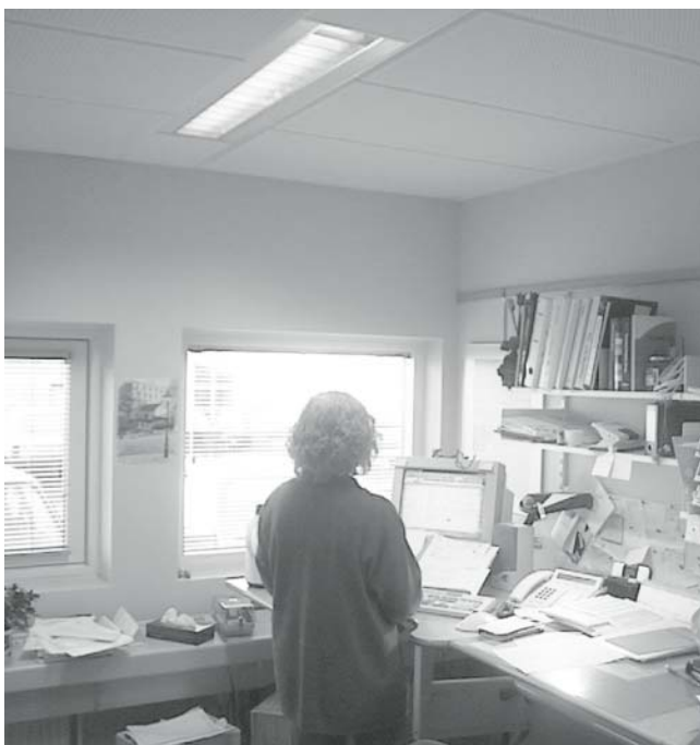
Nordvendt kontor med tændt loftsbelysning på 1. etage. Armaturerne er placeret i lokalets midterlinie.
