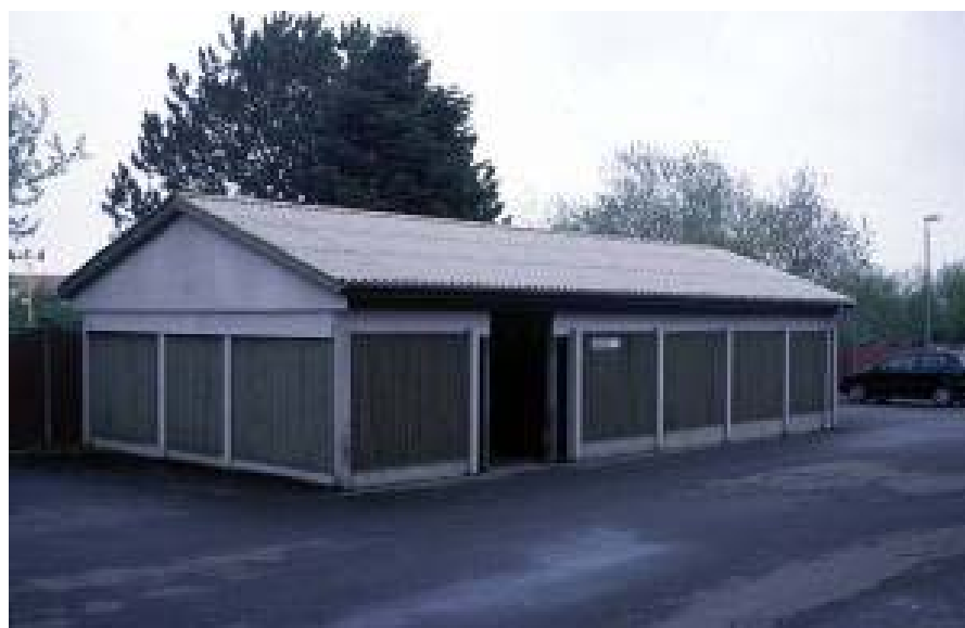
Affaldsstation på et af de to parkeringsarealer
