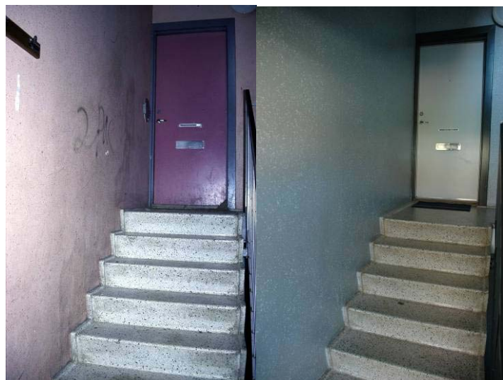
Opgang – før og efter renovering.
