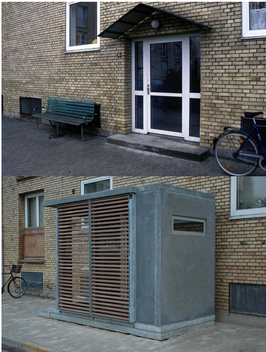
Indgangsparti i ALBOs del af bebyggelsen - før og efter renovering. Det virker helt uforståeligt, hvad den ubehandlede beton skal på dette sted.
