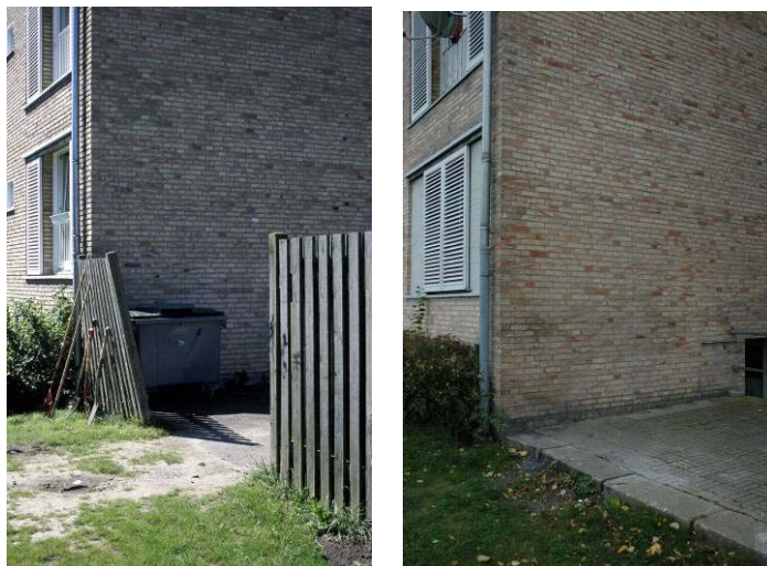
Hjørne ved gavl – før og efter renovering.
