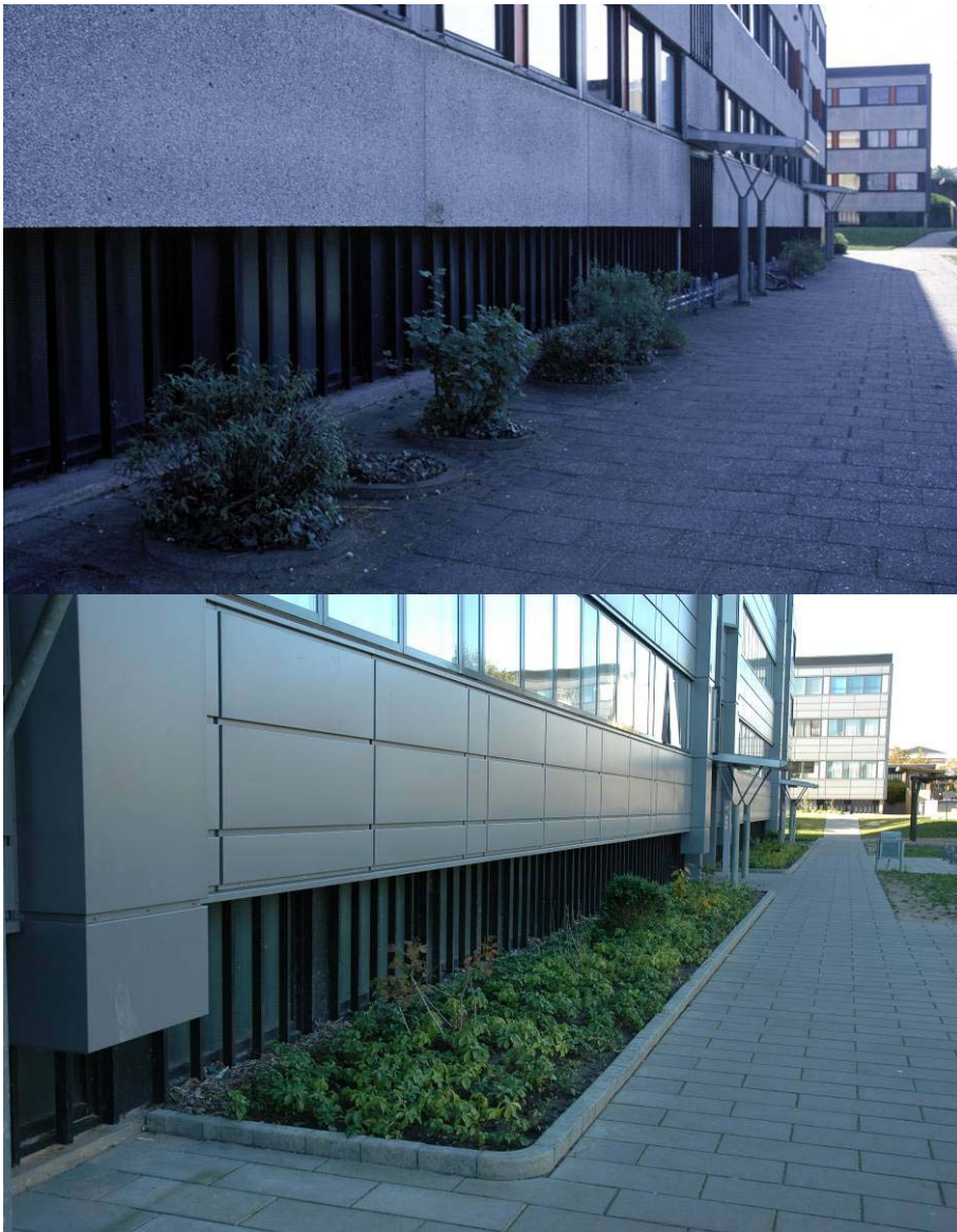
Beplantninger langs ankomstfacader – før og efter renovering.
