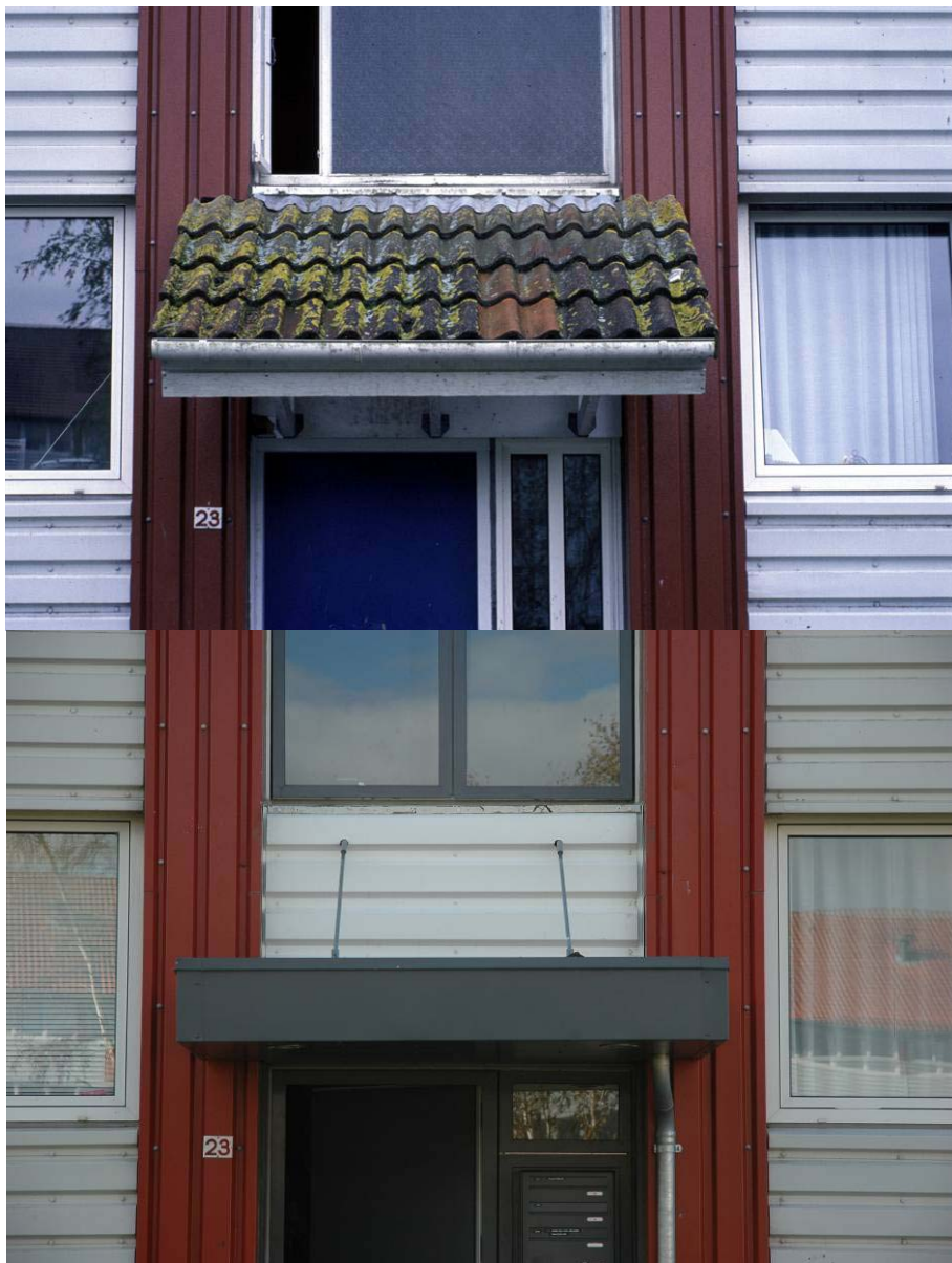
Tagudhæng ved indgangspartierne – før og efter renovering.
