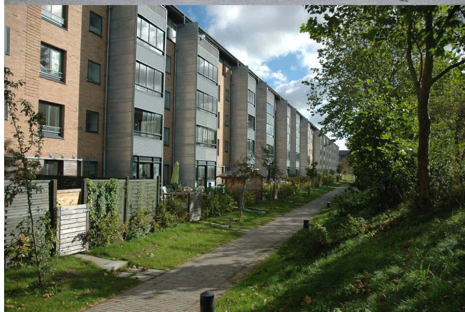
'Gårdfacader' - før og efter renovering.
