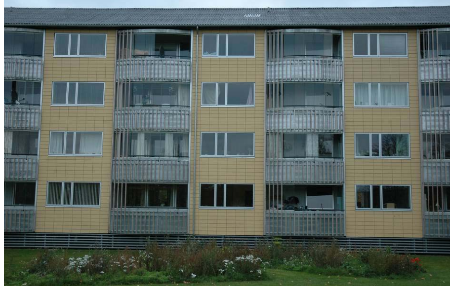
Facade ud mod friarealer i Korsør Boligselskabs del af bebyggelsen - før og efter renovering.
