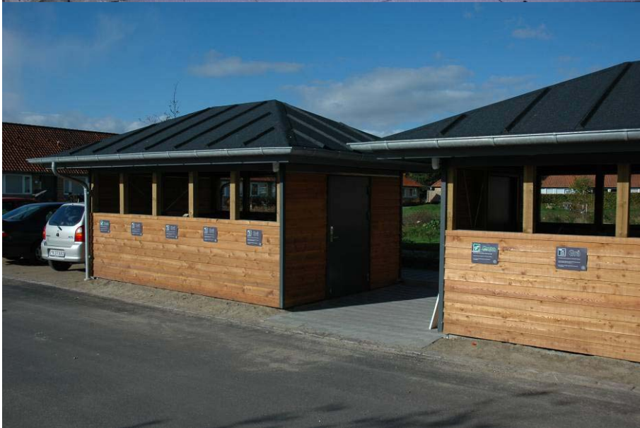
Affaldsstationer – før og efter renovering.
