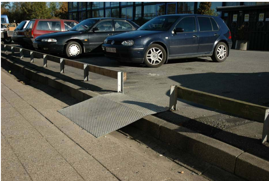
Ankomst til parkeringsarealerne – før og efter renovering.
