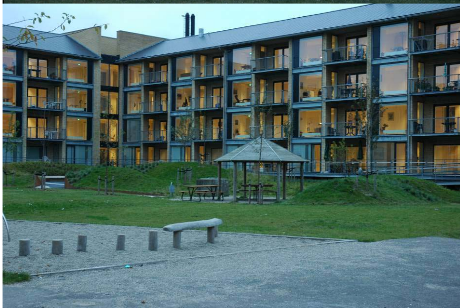
To gårdrum - før og efter renovering.
