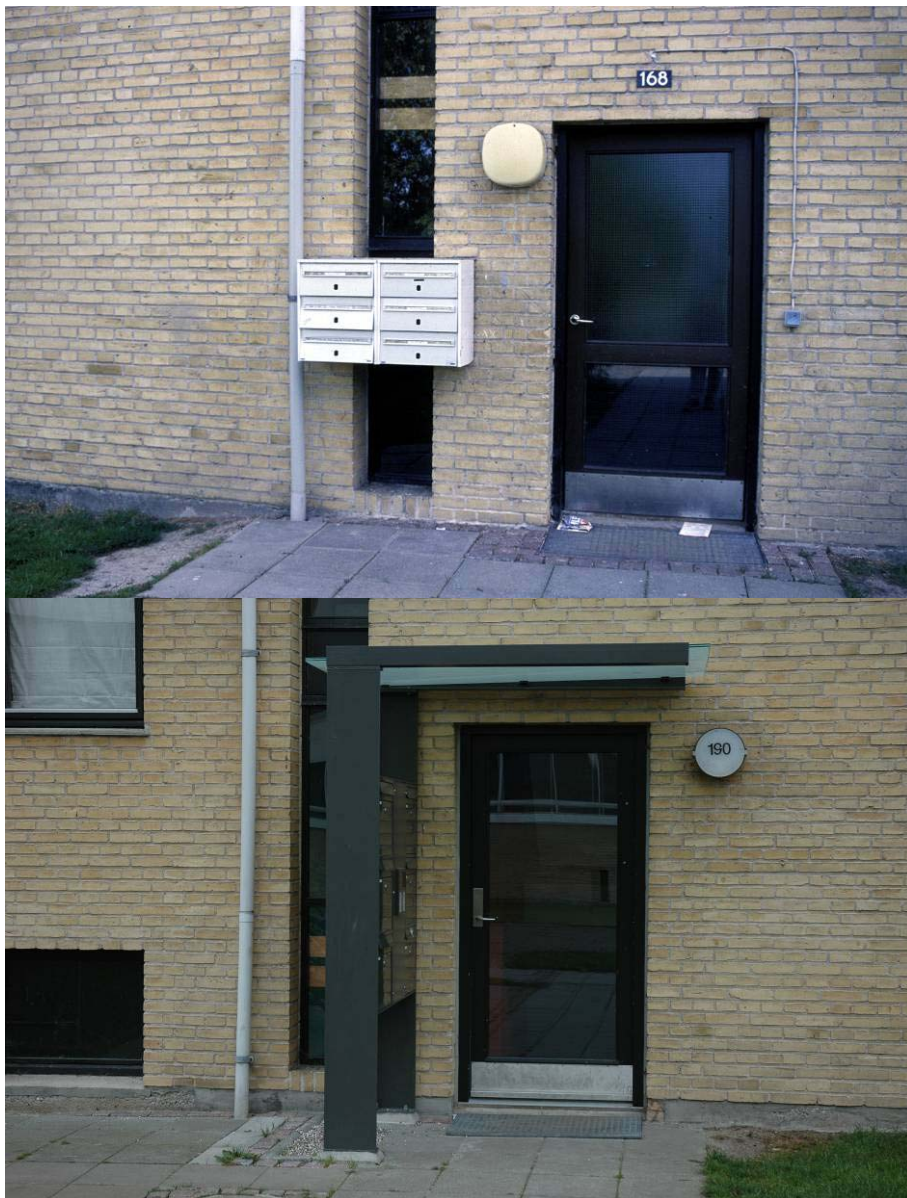
To tilsvarende indgange – før og efter renovering.
