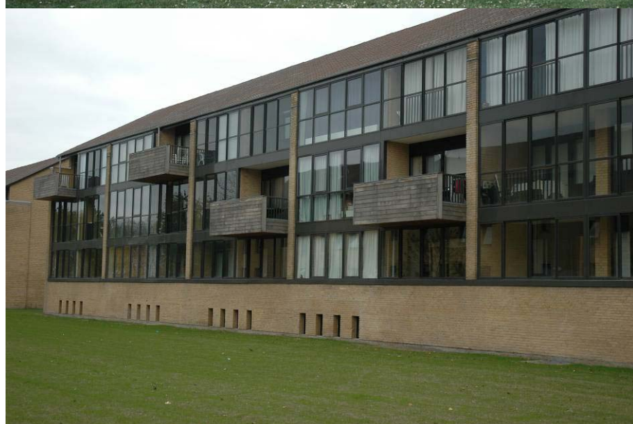
Stueetager i to tilsvarende bygninger– før og efter renovering.
