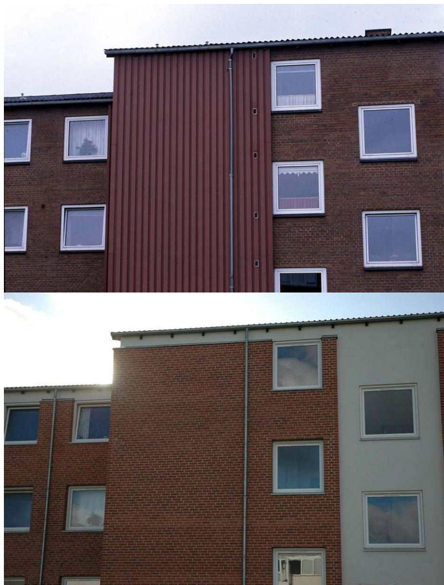
Facadeudsnit – før og efter renovering
