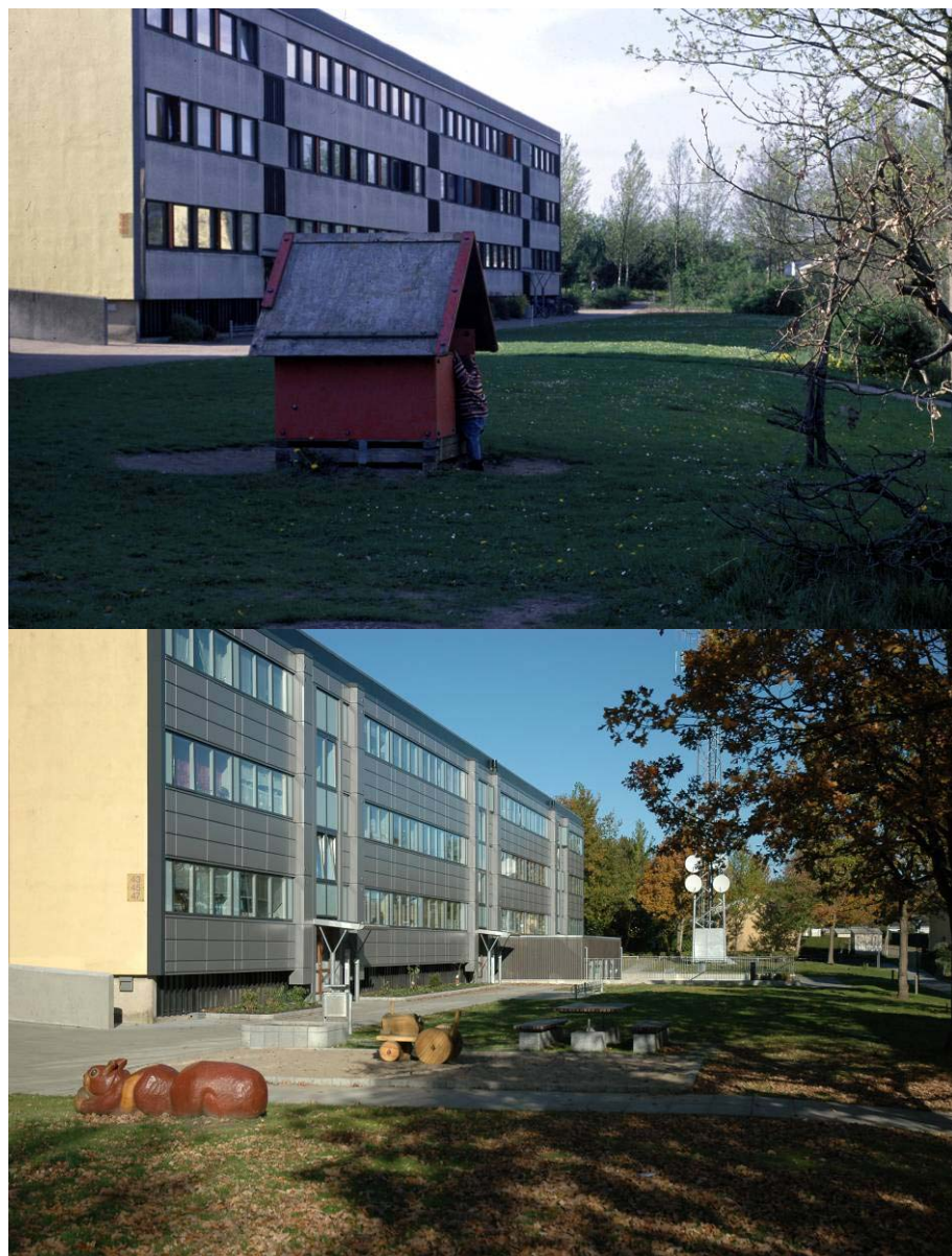
Friarealer – før og efter renovering.
