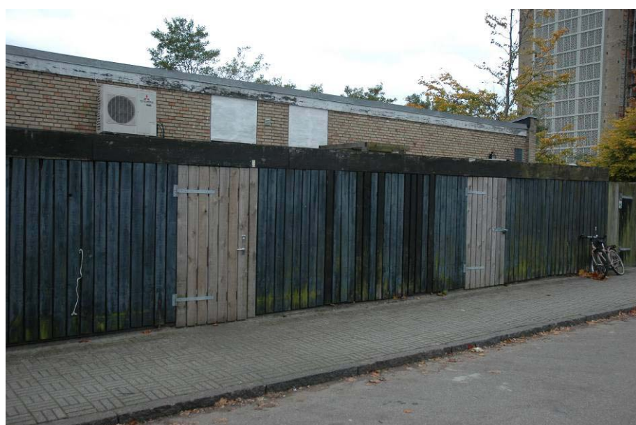
Bagsiden af butiksbygningerne langs Ruten – før og efter renovering.
