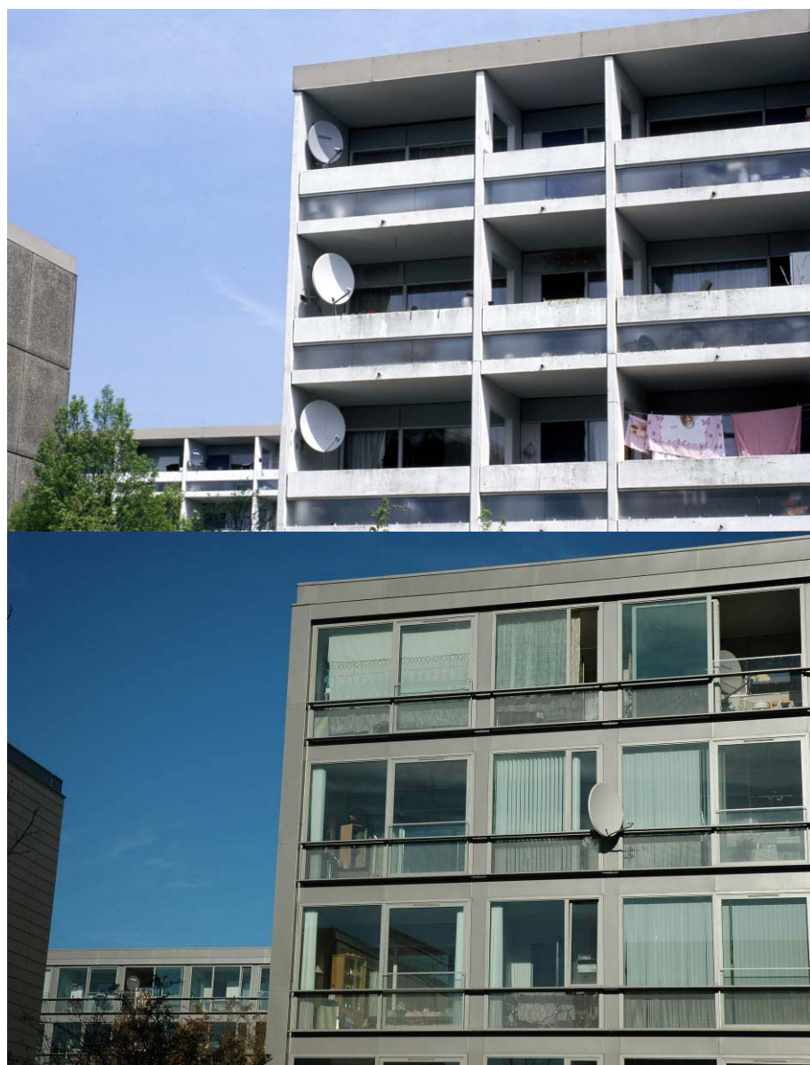
Altaner – før og efter renovering.
