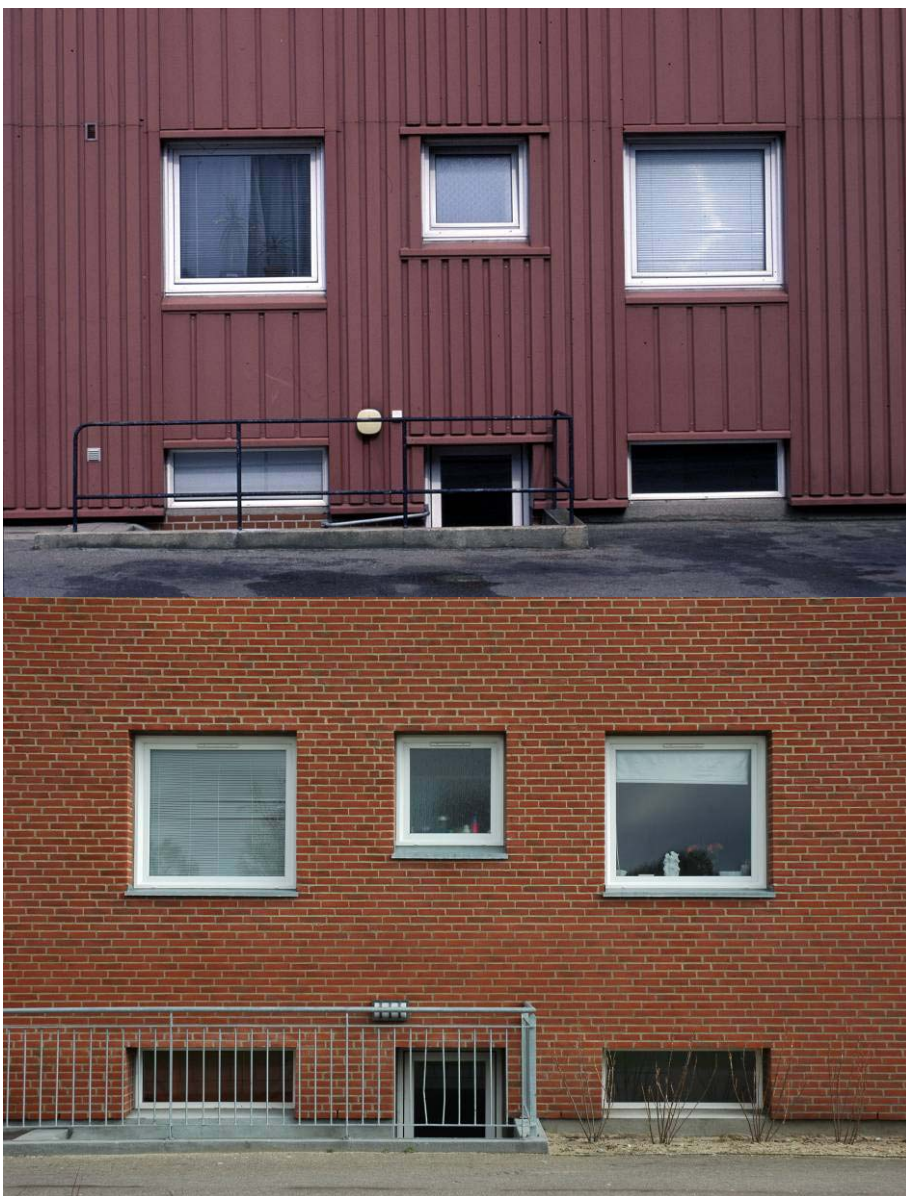
Udsnit af gavl – før og efter renovering
