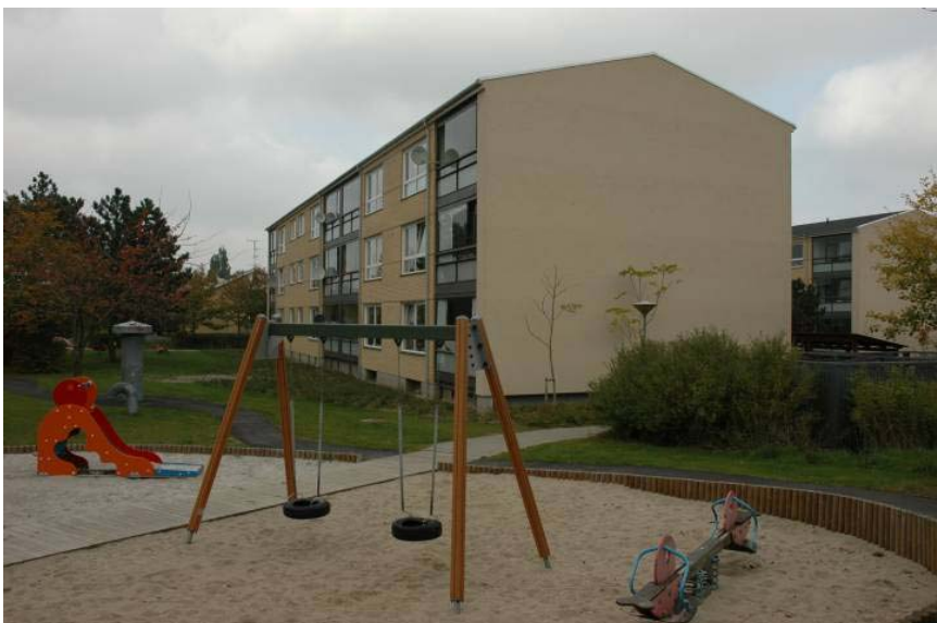
Gavlpartier og friarealer – før og efter renovering.
