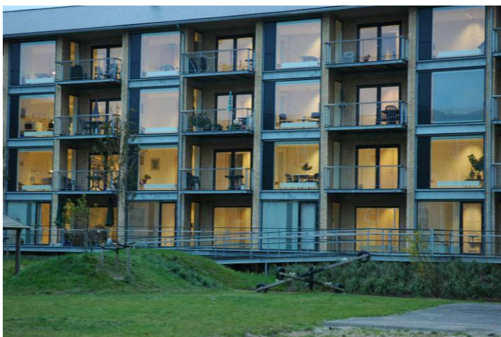
ALBO afdeling 13 – 61 lejligheder er ombygget til plejeboliger.
