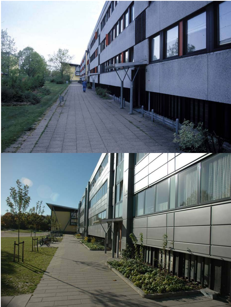
Lange lige stier langs ankomstfacaderne – før og efter renovering.
