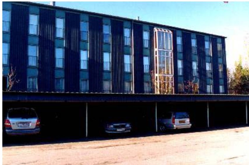
Albertslund Nord før renovering
