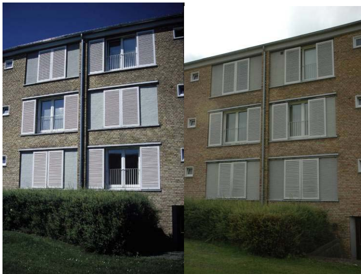
Facadeudsnit – før og efter renovering.
