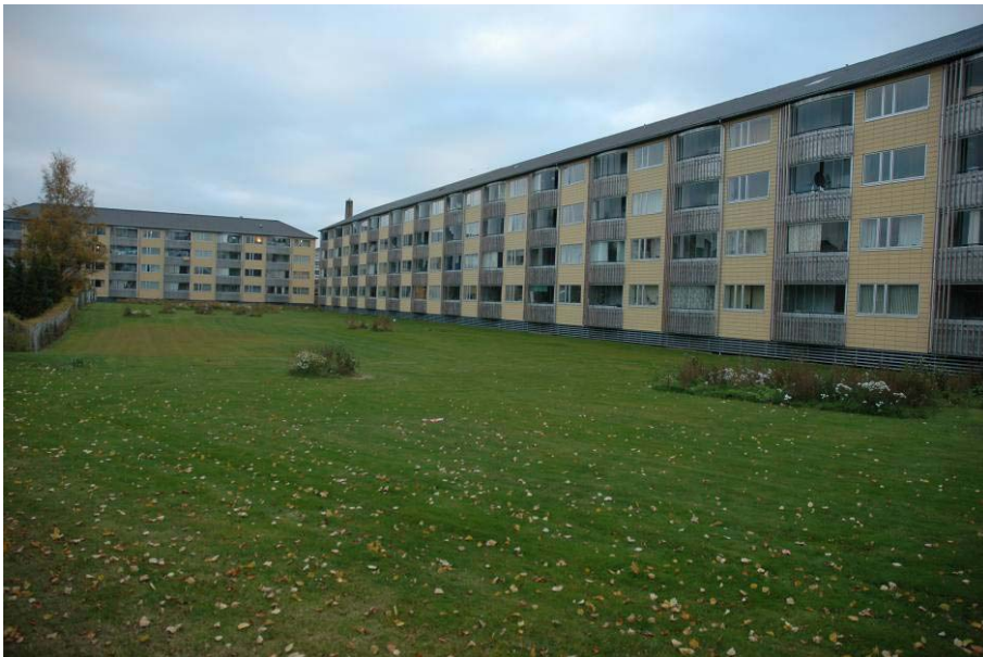
Korsør Boligselskabs del af bebyggelsen efter renovering.
