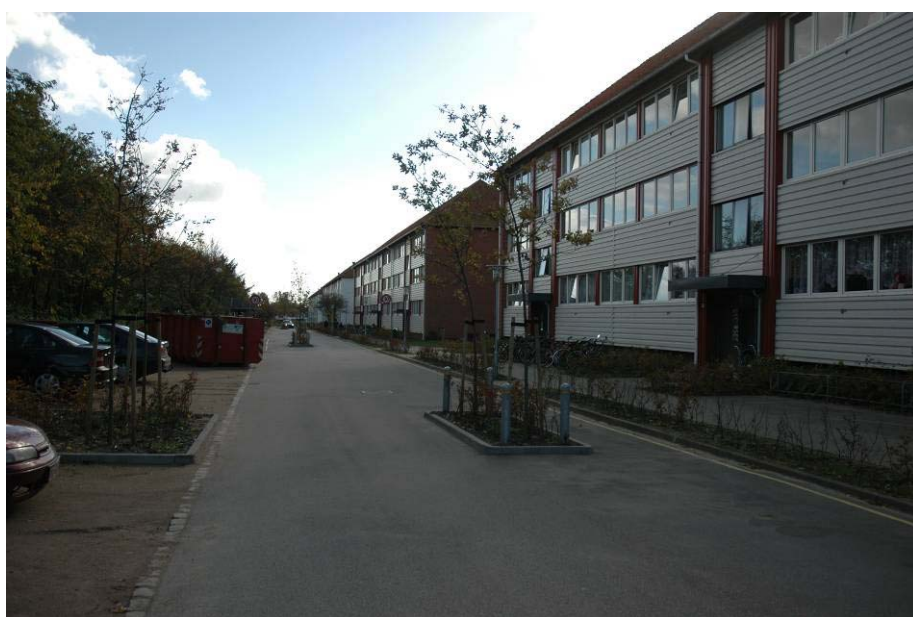
Ankomsten langs Egernvej – før og efter renovering.
