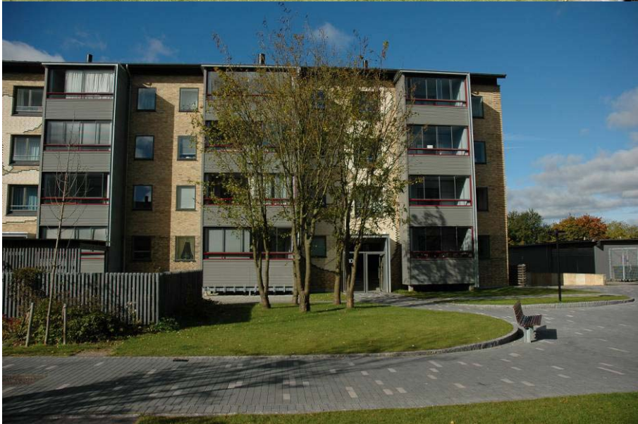
Facadeudsnit – før og efter renovering
