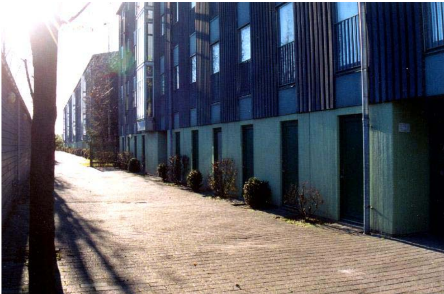
Arealet mellem carportene og de østvendte facader. Et langstrakt areal uden visuel opdeling. Stueetagens mange døre til depoterne er med til at skabe en stemning af 'ingenmandsland'.
