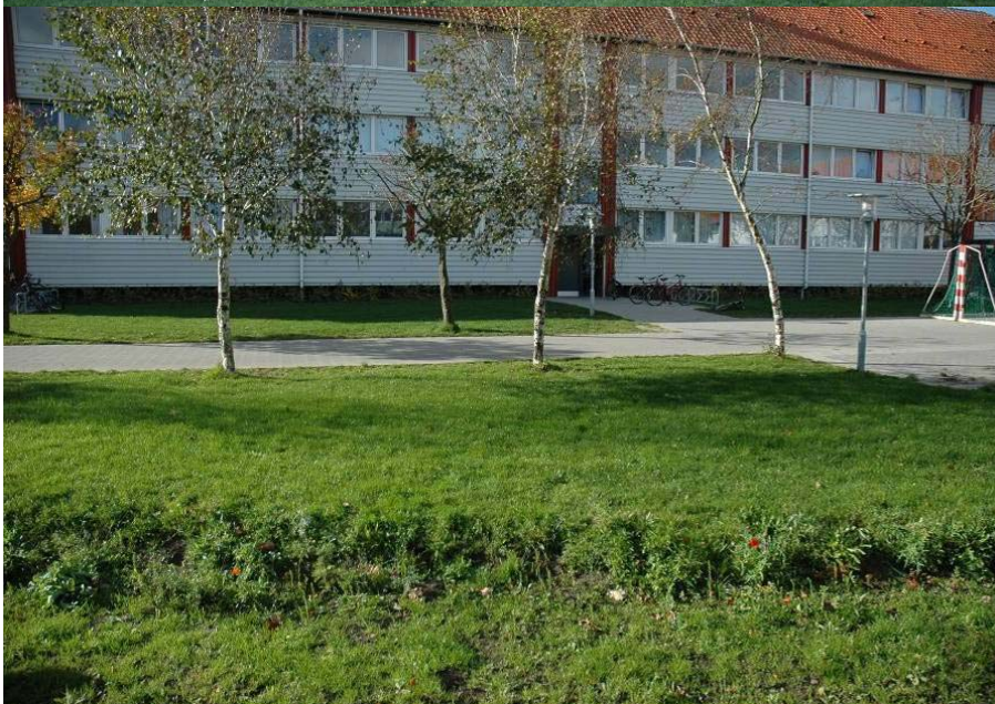
Træer, der fungerede som fodboldmål før renovering. Nye boldbaner har skabt nye muligheder for boldspil.
