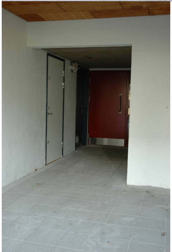
Arealerne omkring kælderdørene – før og efter renovering.
