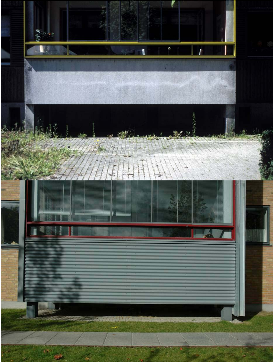
Altantårnenes møde med jorden – før og efter renovering.
