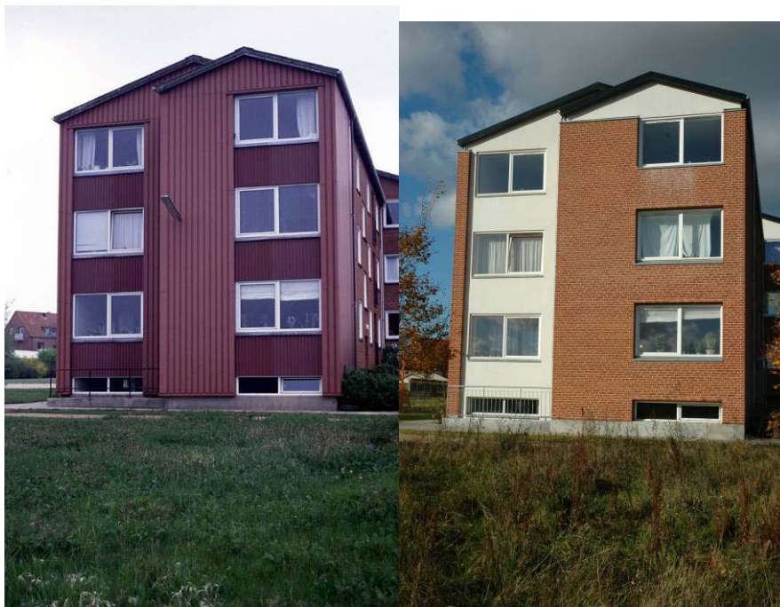
Gavl mod syd – før og efter renovering
