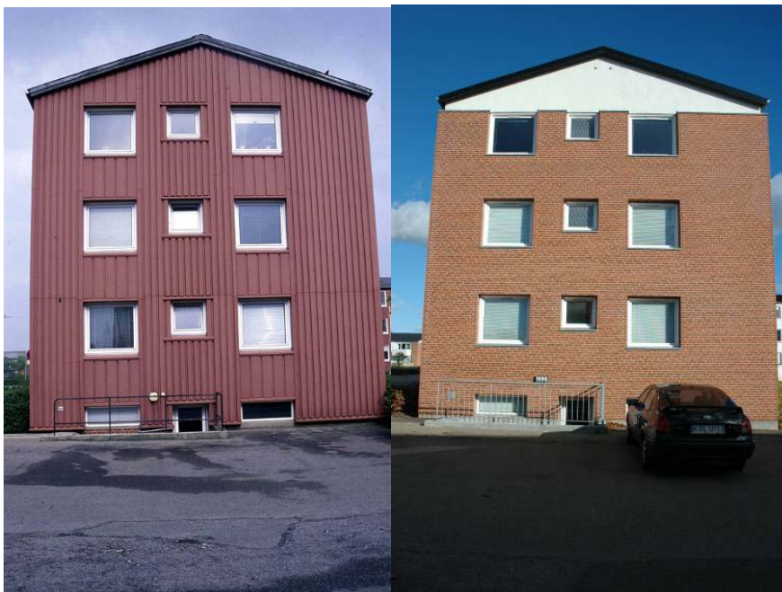
Gavl – før og efter renovering
