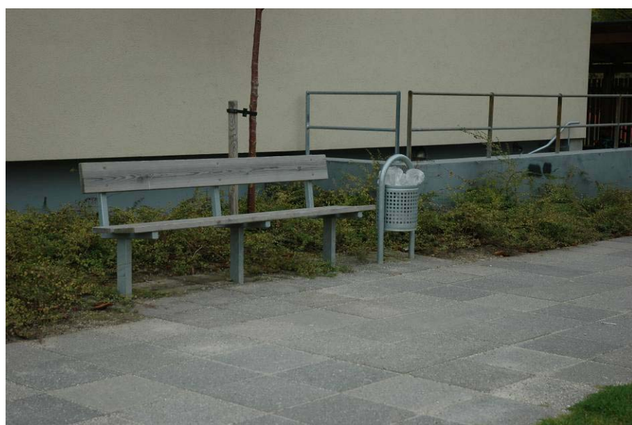
Borde og bænke – før og efter renovering.
