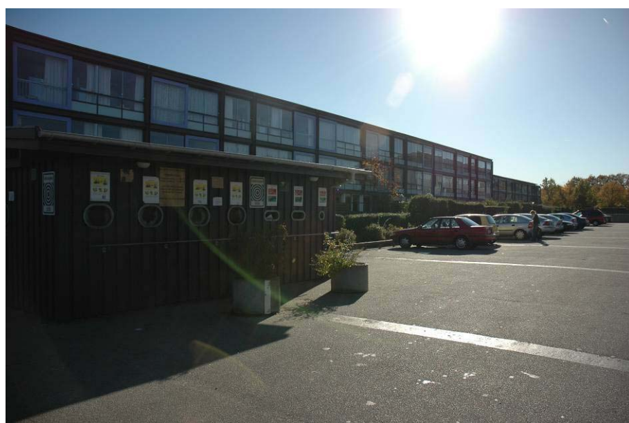
Parkeringsarealer og altanfacader – før og efter renovering. Glasinddækningen af facaderne blev gennemført ved en tidligere renovering.
