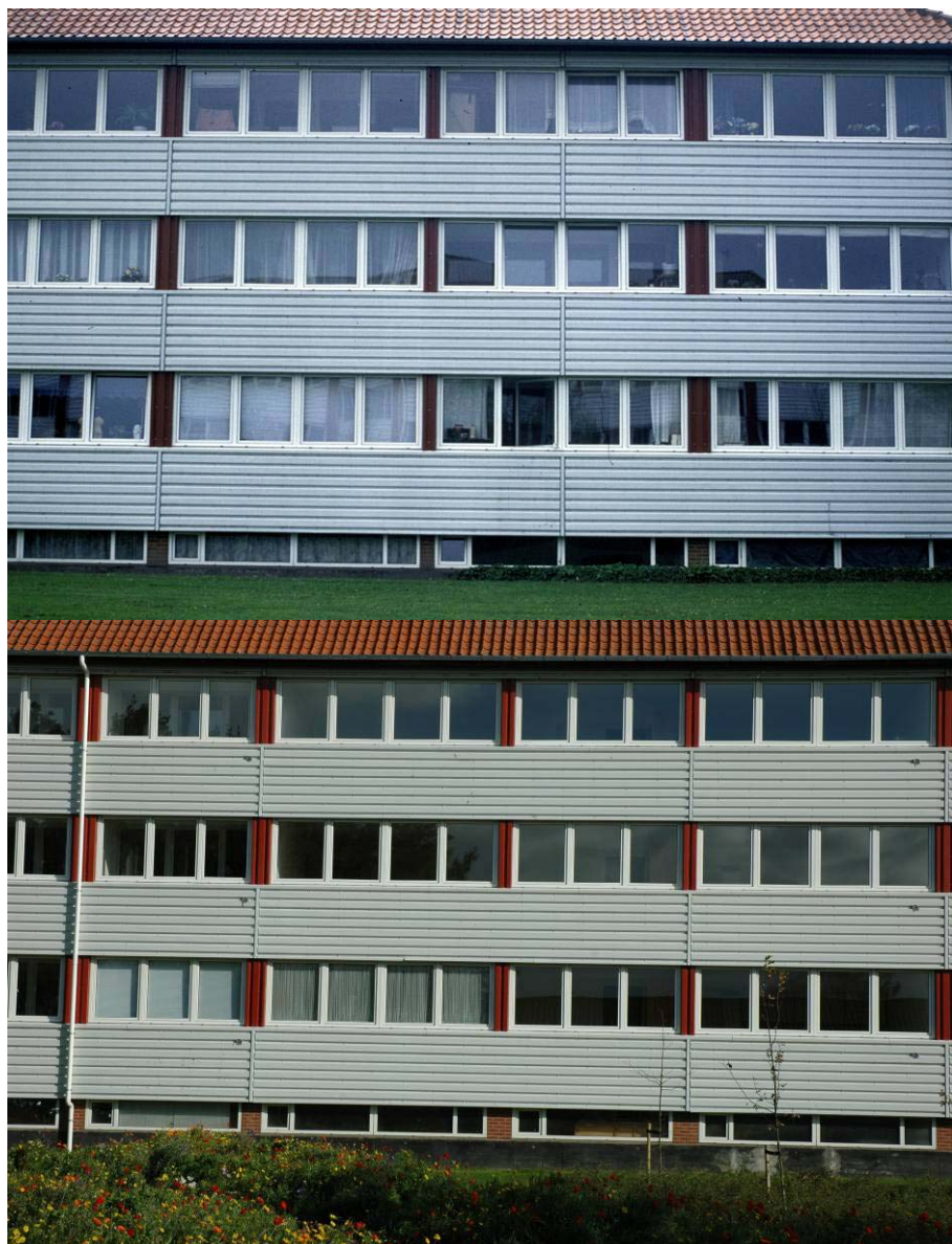
Facaderne ud til de grønne fællesarealer – før og efter renovering.
