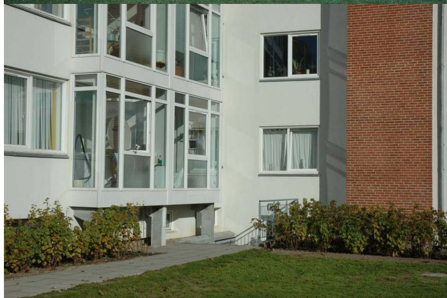
Hjørne i gårdrum – før og efter renovering
