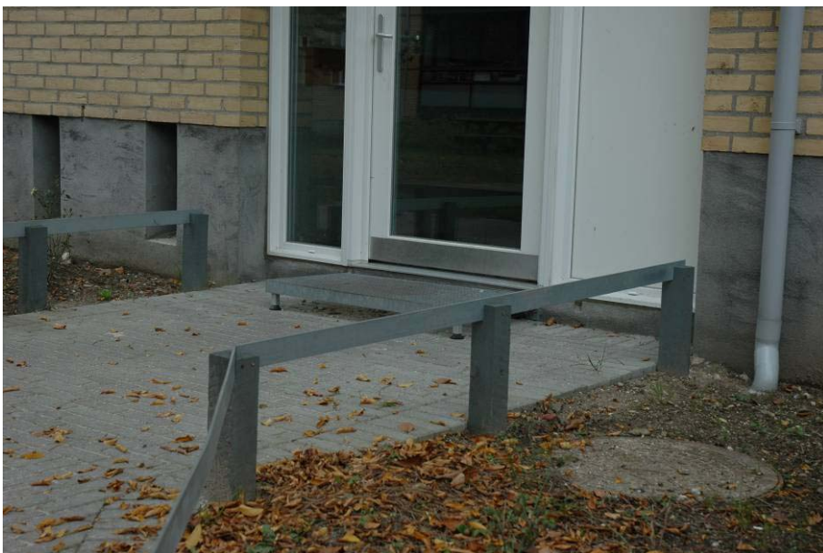
Indgangspartier – før og efter renovering.
