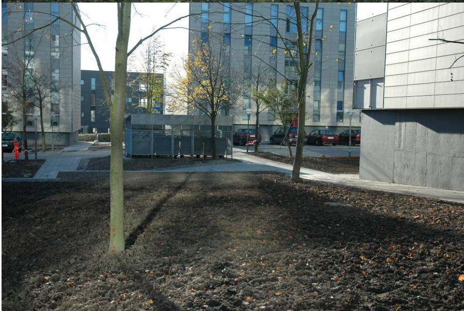
Arealerne mellem modstående gavle – før og efter renovering.
