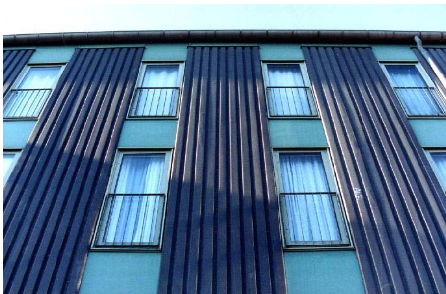
Metalpladerne på de østvendte facade skaber en afvisende karakter.
