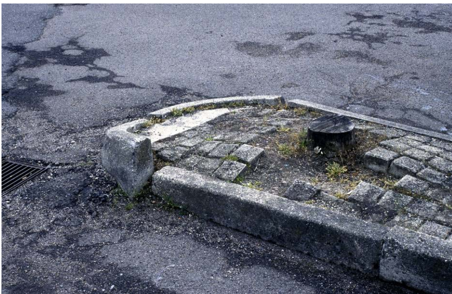
Parkeringspladsen – før renovering. Alle træer er fældet, og tilbage stod de oversavede træstubbe og den ujævne flisebelægning.
