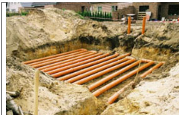
Figur 26: Eksempel på jordrør til forvarmning / køling af friskluft.
