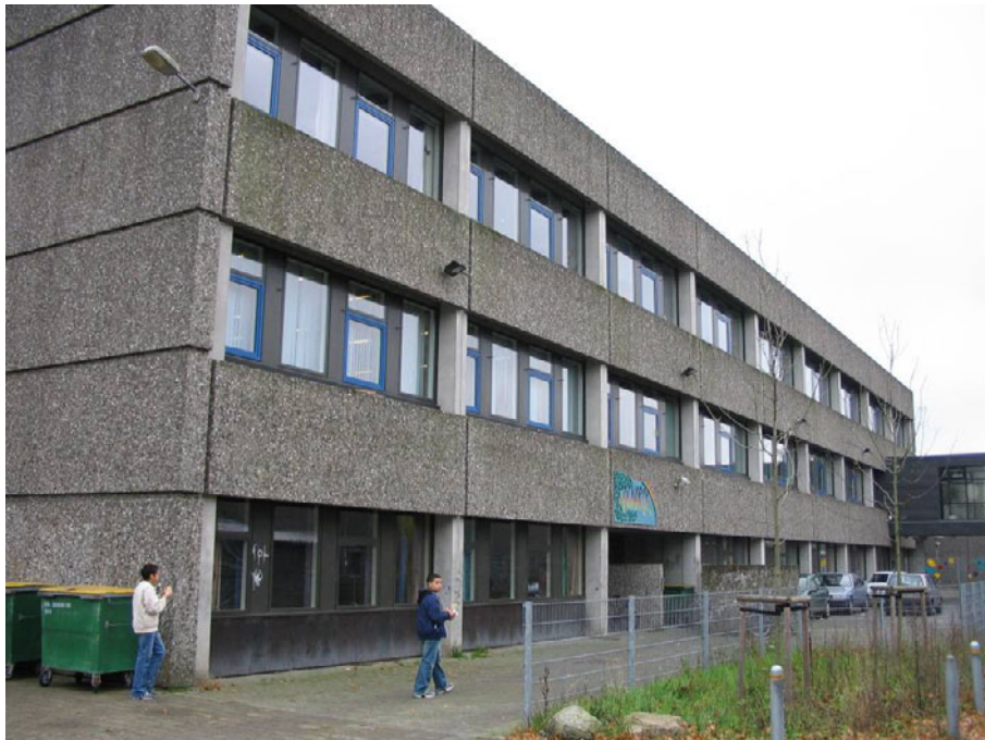
Figur B.2.7.1. Kontorbygning.
