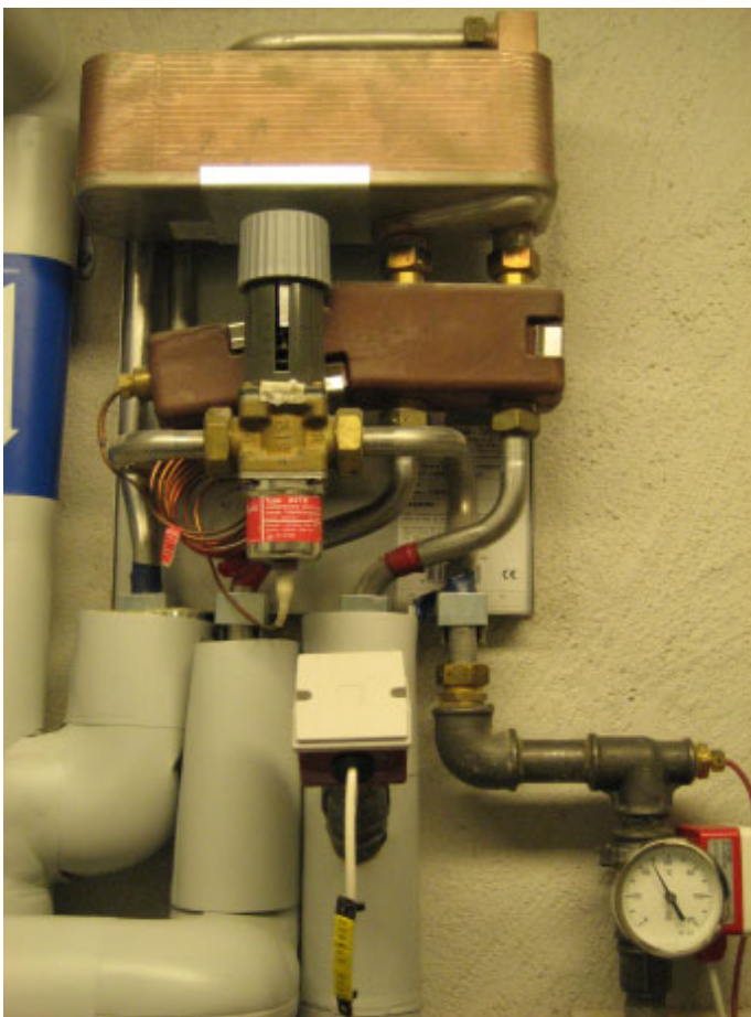
Figur 2.4.1. Uisoleret veksler.
