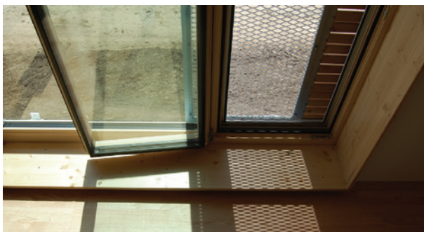
Fig. 25. Solafskærmning er et vigtigt element i energineutralt byggeri. I rækkehusene Lærkehaven I i Lystrup (2008, Arkitekt Herzog+partner) anvendes manuelle skoddesystemer på syd, øst og vestfacader. Skodderne muliggør en afbalanceret udnyttelse af passiv solvarme. Af andre virkemidler i projektet kan nævnes højisoleret og lufttæt klimaskærm, varmeakkumulerende loftpanaler med phase change materials, brug af LED lys, samt anvendelse af FSC certificeret træ. (Boligforeningen Ringården 2014)
