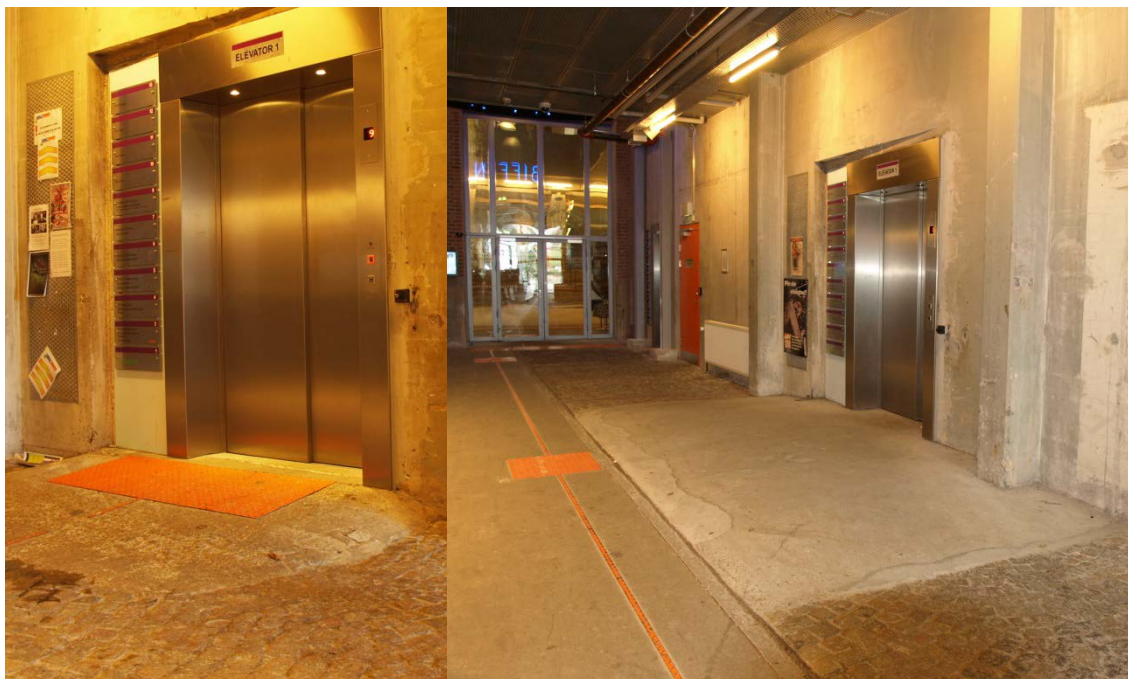
Illustration 16: Til venstre ser man den oprindelige løsning med en alt for stejl opkørsel foran elevatoren i Teatersmøgen (foto, dec. 2012). Til højre: En ny og meget mindre stejl opkørsel er blevet støbt. Dog mangler man at reetablere ledelinje og opmærksomhedsfelt (foto, juli 2013).
