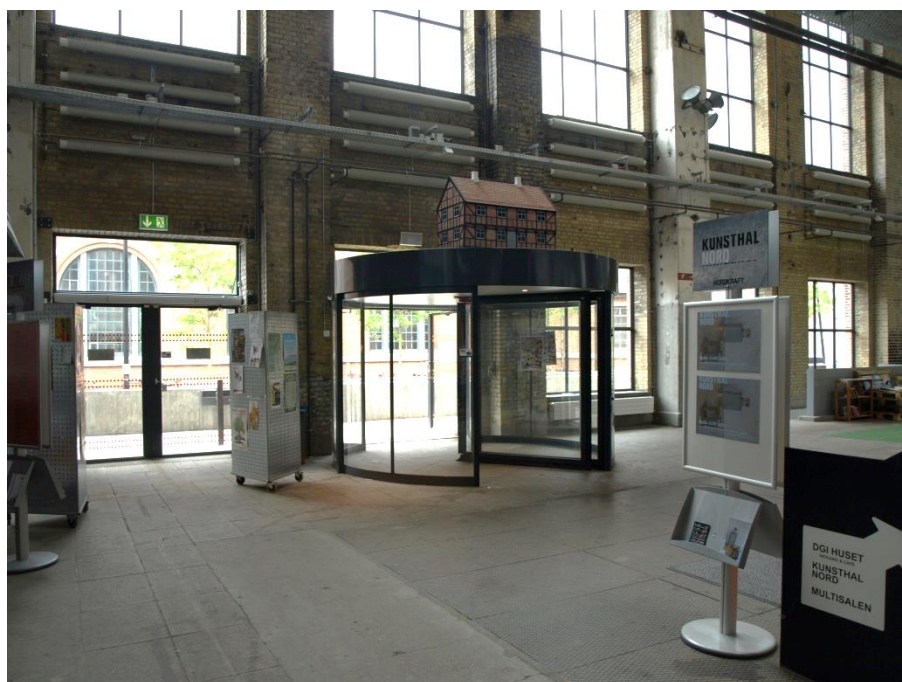
Illustration 10: Fra Kedelhallen, hvor en sluse er blevet sat op efterfølgende. Man har glemt at reetablere ledelinjen – den orange pil angiver hvor den oprindelige linje var placeret; man kan se mærker efter den.
