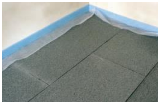
Figura 6. Detalle de instalación de un Suelo flotante con EEPS
