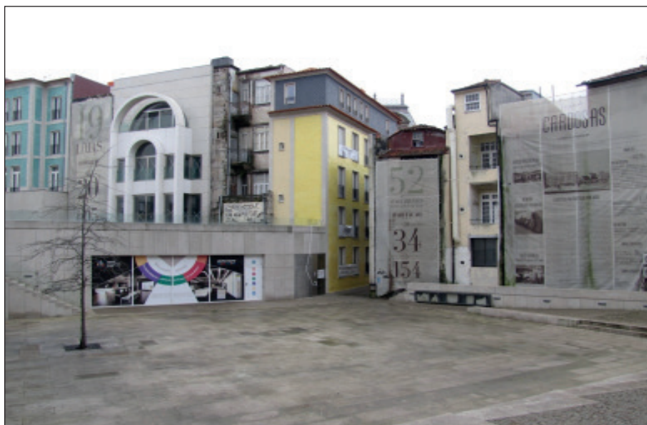
Figura 9. Aspeto do quarteirão das Cardosas no centro histórico do Porto.
