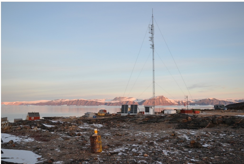
Den eksisterende, ikke benyttede, telemast i Qeqertat
