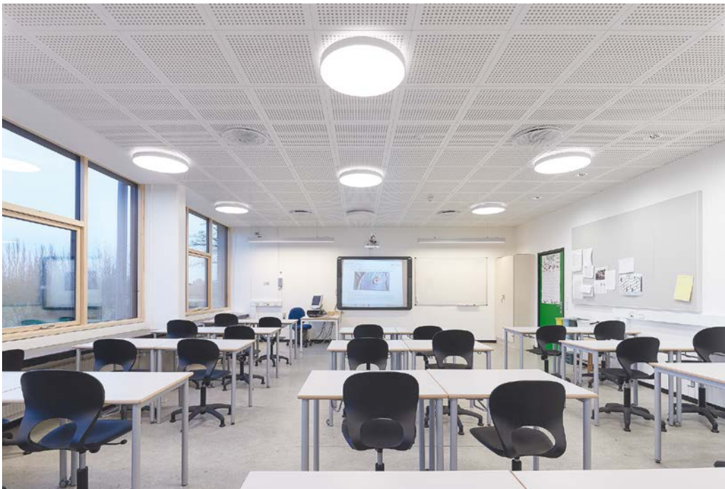
1. SMARTBOARD: Allmänbelysning 300 lux/3 500K, tavelbelysning 300 lux/3 000 K och wallwash 300 lux/4 000 K.
