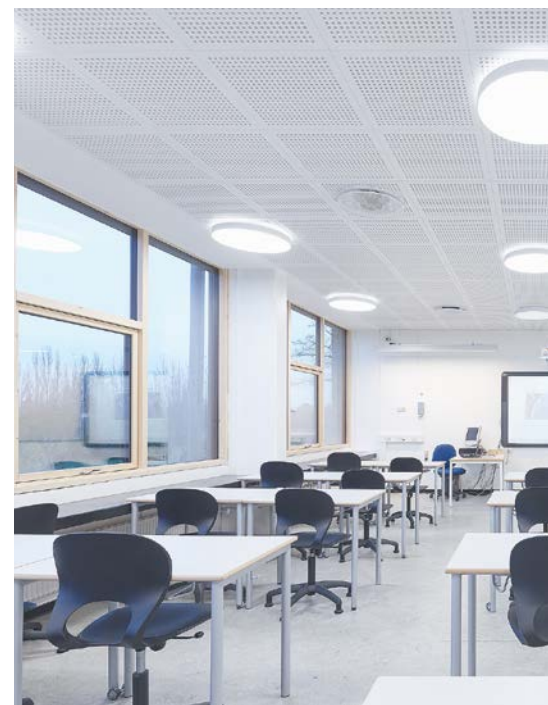
2. AKTIVT: Allmänbelysning 500 lux/5 000 K, tavelbelysning 500 lux/3 000 K och wallwash 420 lux/4 000 K.
