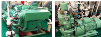
(d) diesel generator (e) pump load
