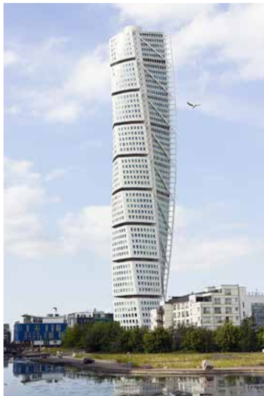
Turning Torso v. Santiago Calatrava på Malmös Västra Hamn
