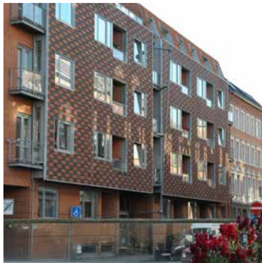
Facaden på 'det grønne hus'/nybyggeriet mod Louisegade
