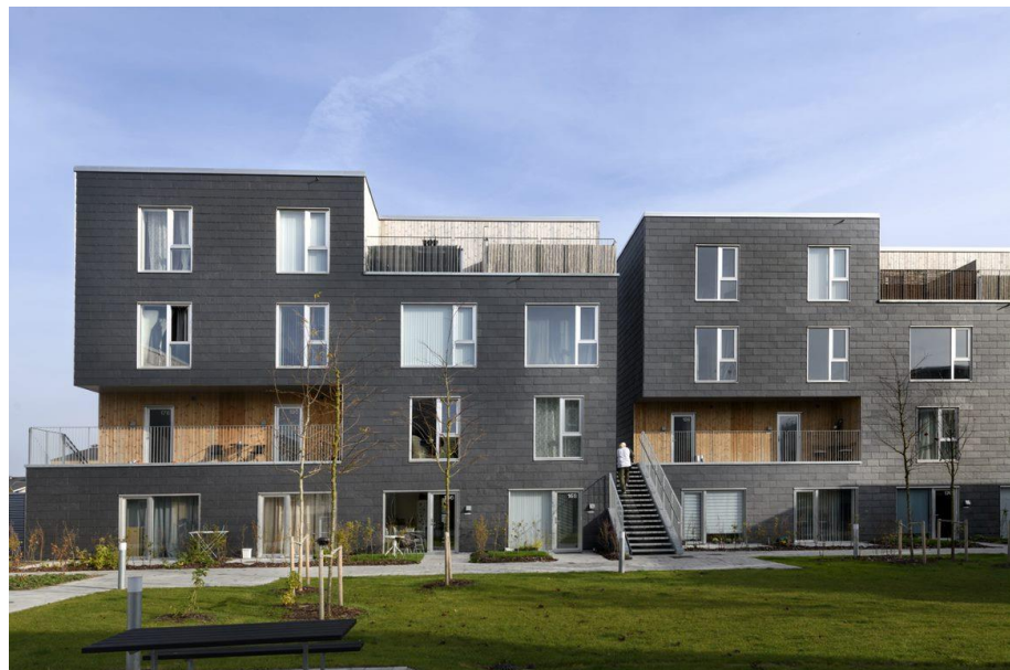
Figur 14. Byggeri i træ i op til fire etager med mindre end 9,6 meter til gulv i øverste etage. Foto: Scandibyg.
