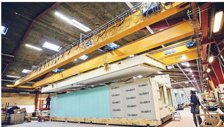
Figur 38. Modulbyggeri under kontrollerede vejrforhold udført i overdækket hal. Rummodulet monteres tagkassette. Foto: Scandibyg.
