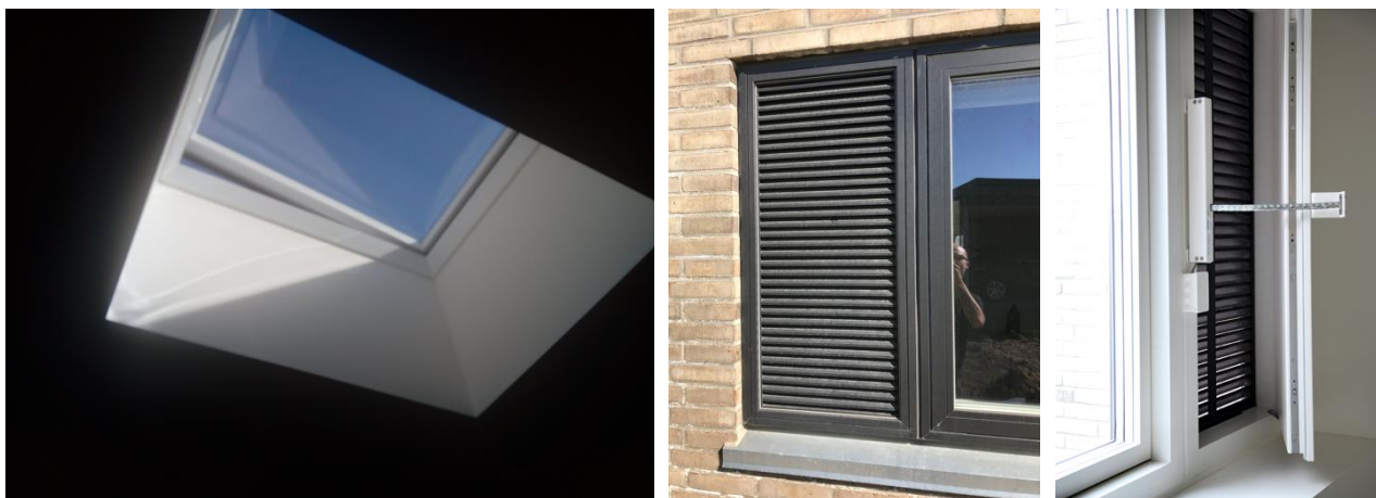
Figur 2 Ovenlys/taglem, samt ventilationskodde set ude- og indefra
