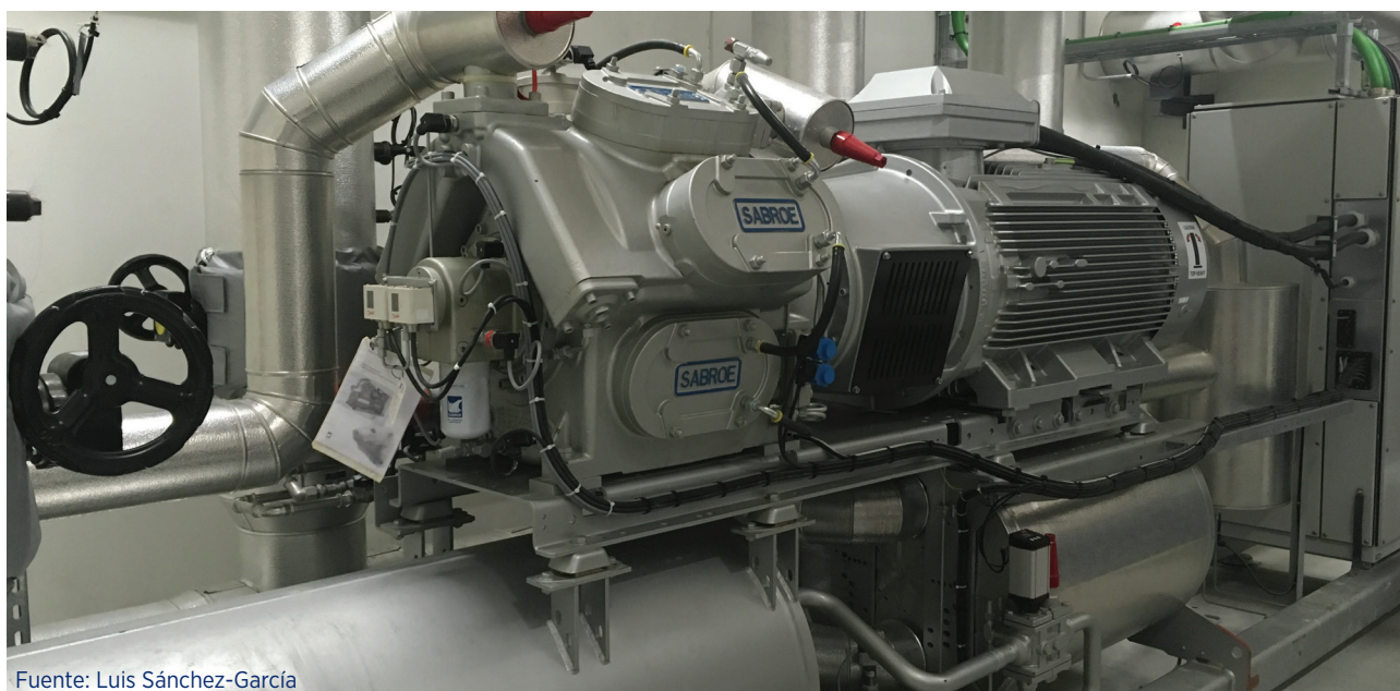
Fotografía 3 Bomba de calor por compresión que suministra a una red de calefacción urbana en Dinamarca
