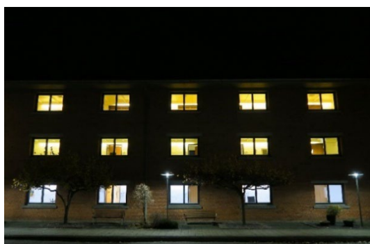
Figur 2-1 - I stueetagen ses det nye LED-belysningssystem på 1. og 2. sal ses den eks. belysning med kompaktlystofrør
