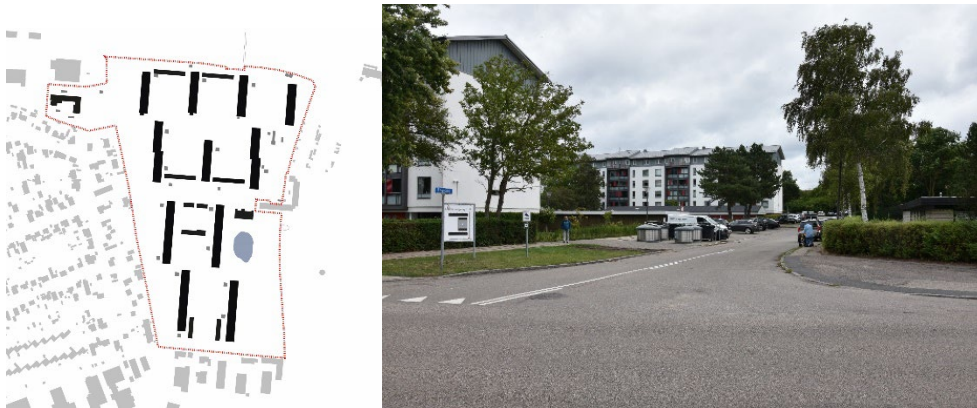
FIGUR 9. Tv. Kortet viser forskel på bebyggelsesstruktur, bygningstyper og bygningsvoluminer mellem Agervang (indrammet med rødt) og de omkringliggende kvarterer. Den hvide farve på kortet viser de store helt og delvis ubebyggede arealer f.eks. Holbæk Fælled og Holbæk Have, som grænser op til boligområdet Agervang. Th. Boligblokkene fremstår massive og høje ift. de enetages bebyggelser på den modsatte side af vejene Engvej og Mellemvang.
