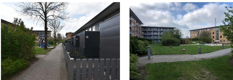
FIGUR 6. Tv. Sti i den nordlige del af Sundparken mellem to toetages bygninger, hvor den ene er udformet som rækkehuse med private haver og den anden består af ungdomsboliger. I baggrunden ses de firetages boligblokke. Th. Variation i de firetages boligblokke, hvor hovedparten af blokkene har trappeopgange, og enkelte har altangange.
