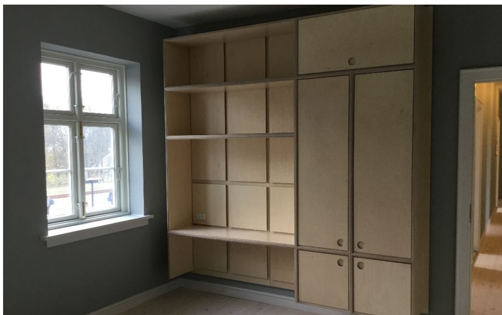
FIGUR 15. Modulerne udført som møbelvægge i træ, der gør det nemt at aflæse, hvad der er eksisterende dele, og hvilke dele der er nye. Foto: Niels Haldor Bertelsen (2020).
