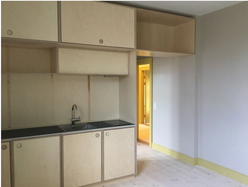
FIGUR 17. Køkken er opbygget af modulsystemet, og materialeskiftet viser tydeligt forskel på det eksisterende og de nye elementer. Foto: Niels Haldor Bertelsen (2020).
