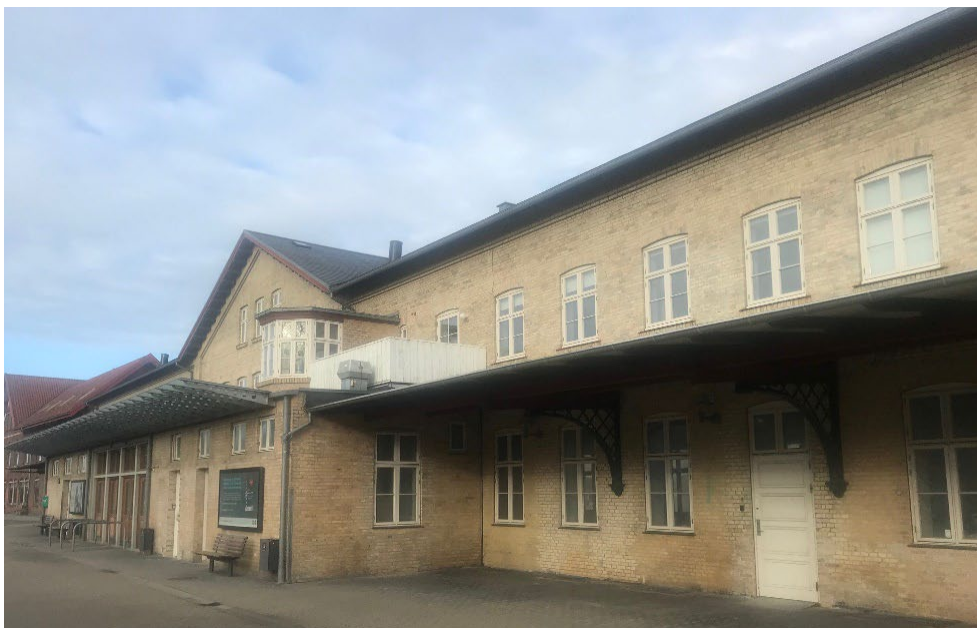
FIGUR 14. Modulforsøget gennemføres indvendigt på 1. sal på Hjørring Station. Her ses bygningen fra siden ud mod togskinne. Foto: Lene Wiell Nordberg (2020).
