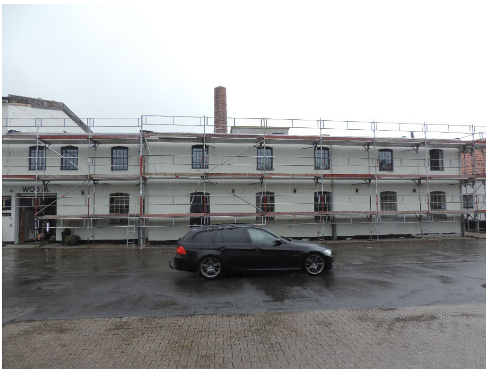
FIGUR 18. I nordfacaden er isat nye sprossvinduer. Foto: Niels Haldor Bertelsen (2020).
