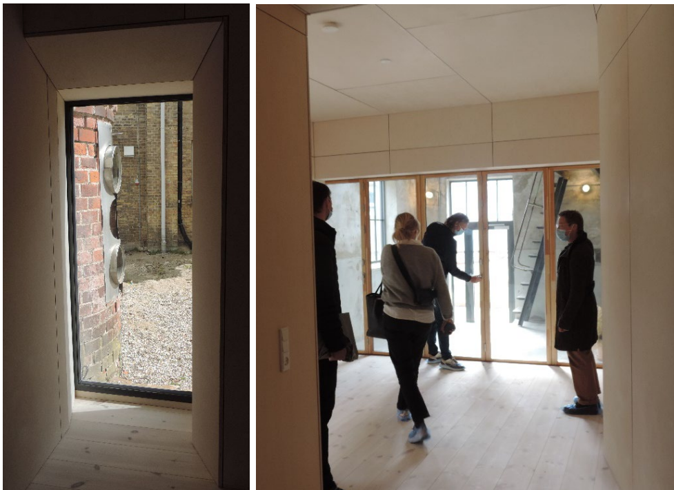
FIGUR 29. Stueetage i 2-etagers lejlighed, som ved besøget ikke er udlejet. Til venstre udsigt til skorsten gennem vindue, som før var en åbning for 3 røgrør fra kedelrummet. Til højre er stuen med udsigt til uopvarmet rum og trappen til 1. sal. Foto: Niels Haldor Bertelsen (2021).
