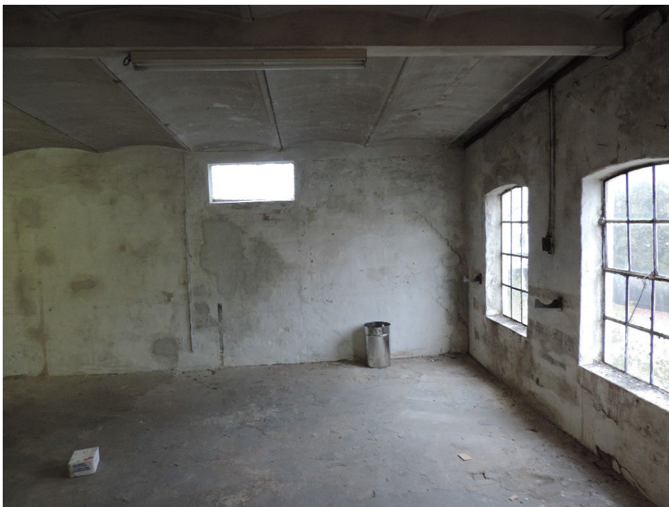
FIGUR 11. Et rå fabrikslokale med romerdæk. De gamle fabriksvinduer ønskes bevaret efter transformationen af fabrikshallerne til lejeboliger. Foto: Niels Haldor Bertelsen (2019).
