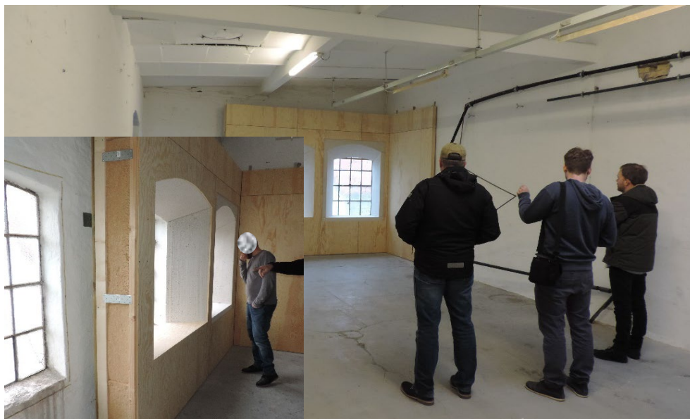
FIGUR 14. Prototype af 'Hus i Hus' konceptet med eksempel på yder- og indervægselement er opsat for enden af et rum i fabriksbygningen. Foto: Niels Haldor Bertelsen (2019).
