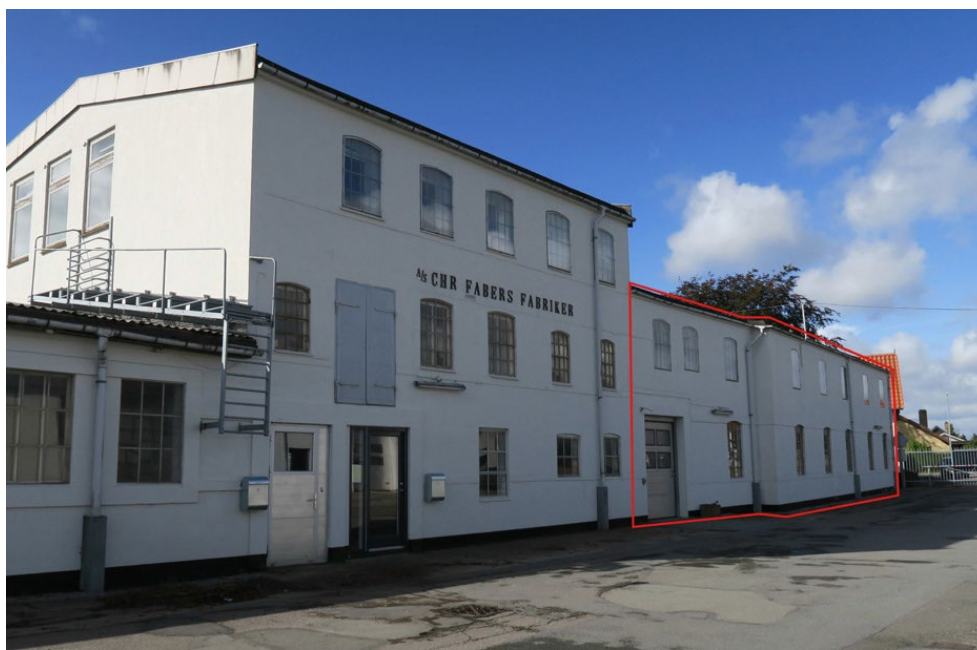
FIGUR 6. Forsøgsbyggeriet omfatter den vestlige del af de ældst bevarede produktionshaller på Fabers Fabrikker, som er fra 1920'erne. Facaden på disse produktionshaller fra 1920'erne er vist på dette billede med rødt, og på situationsplanen er det bygning 2. Kilde: [Faaborg, A03].
