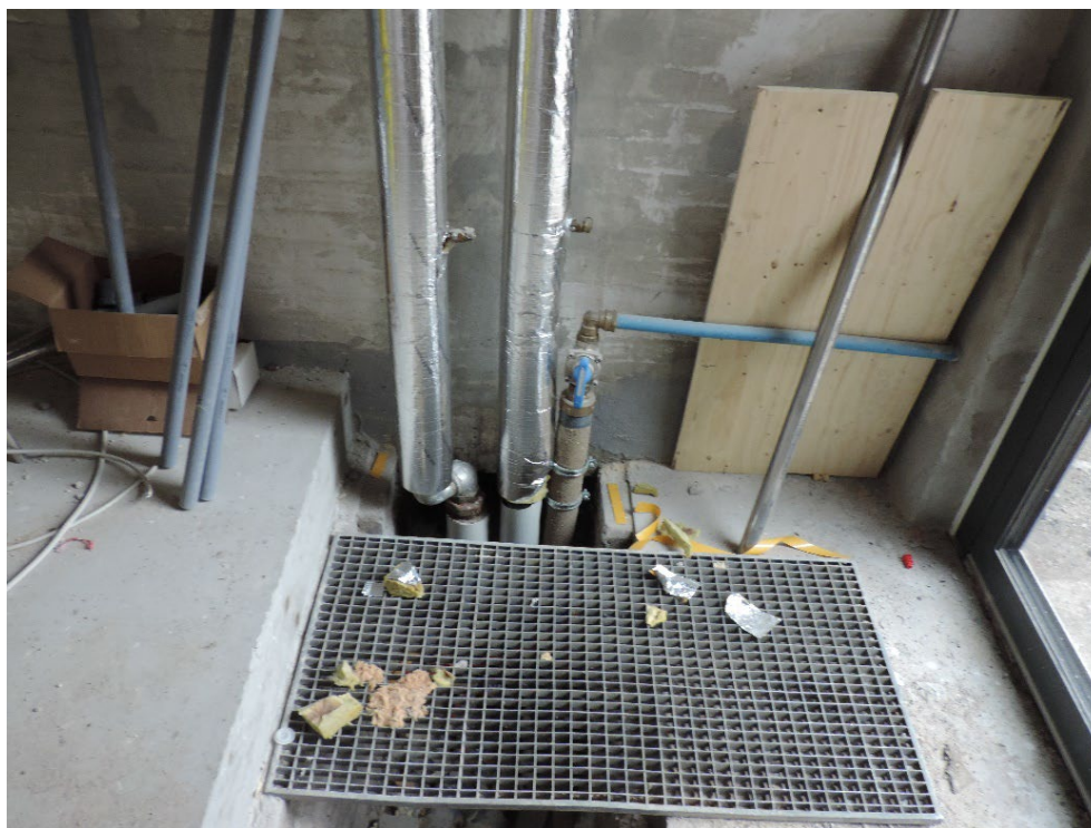
FIGUR 16. Gulvet sikres mod opsivende forurening fra undergrunden ud fra en § 8-ansøgning. Foto: Niels Haldor Bertelsen (2020).
