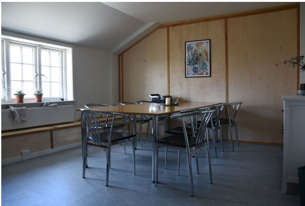
FIGUR 8. Et af de nye fællesrum. Langs den hvide ydervæg ses den 'bænk', der giver plads til al ledningsføring, mens de nye modulsystemer i birkefiner ses for endevæggen. Foto: Claus Bech-Danielsen (2018).
