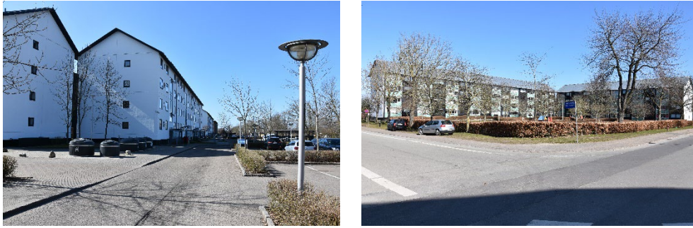
FIGUR 4. Facadeudtrykket i Schakenborgvænge adskiller sig fra den øvrige bebyggelse i Ringparken med hvide pudse facader og sorte vinduesbånd.
