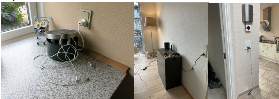
Billede 13-15 Opladning og ledninger hos henholdsvis MJ2, NJ4 og MJ3
