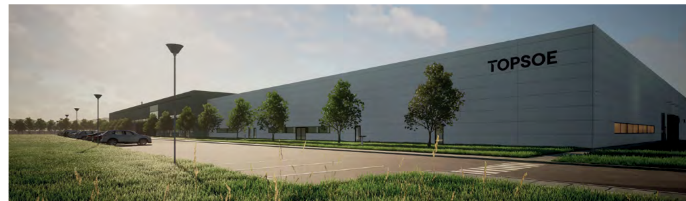
Figur 19: Visualisering af Topsoes SOEC-produktionsfabrik, der er designet til årligt at producere SOEC svarende til 500 MW elektrolyse fra forventeligt 2025 med muligheder for at udvide til 5 GW.
