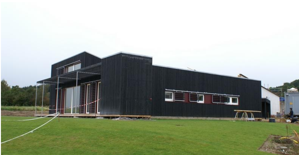
Figur 3.2: Stenagervænget 39 fra sydøst.
