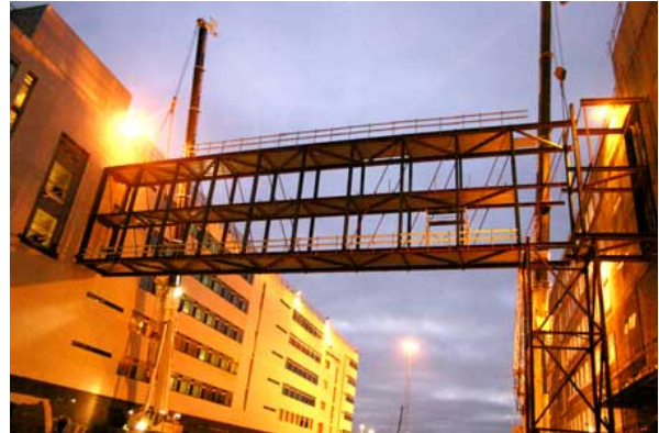
Gangbro mellem bygningerne ved dens montage.
