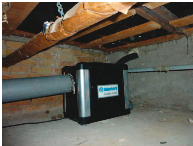
Figur 11. I supplerende forsøg i Rosendalen 331 blev der anvendt en affugter med integreret ventilator.
