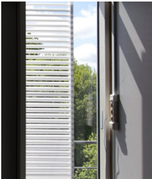
Figur 30. Energy Frames element med indbygget lamelafskærmning. Foto: Art Andersen.
