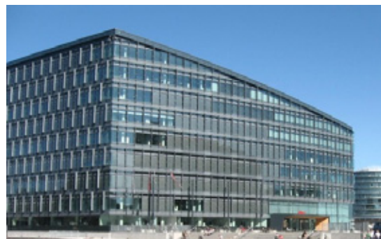
Figur 5. Bygning med store glasfacader, der i teorien giver et godt udsyn, men som i praksis må beskyttes med screendug, som forringer eller i værste fald blokerer for udsynet.
