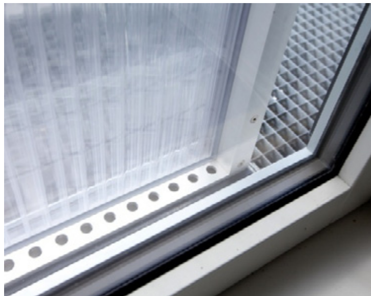
Figur 40. Energy Frames ventilationselementet med forskydelige hulprofiler indbygget foroven og forneden, således at åbningerne kan reguleres. Foto: Forfatterne.
