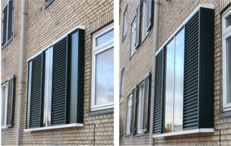
Figur 47. Foto af prototyperne på de to typer nyudviklede lydkodder, dels med samlet spalteåbningsareal på 0,14 \text{ m}^2 (til venstre), dels 0,35 \text{ m}^2 monteret (til højre). Foto: Art Andersen.
