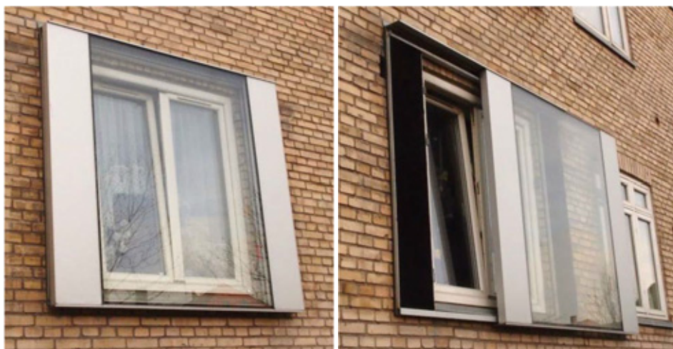
Figur 46. Fotos af lydskoddens udseende og funktion. På fotoet til venstre ses den lukkede lydskode, til højre lydskodden kørt til siden. På begge fotos er det eksisterende side-bundhængte, indadgående vindue åbnet i ventilationsstilling. Foto: Art Andersen.
