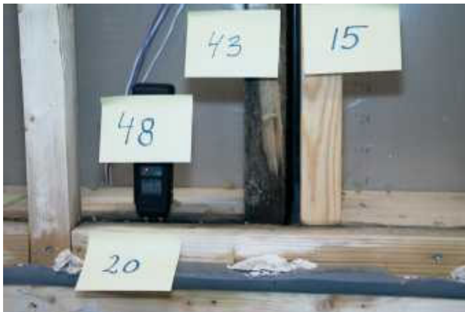
Figur 34. Eksempel på hvor kraftigt fugtindholdet kan variere selv indenfor små områder. På billedet ses resultatet af 4 målinger af fugtindholdet (vægt-%) omkring detalje 12.
