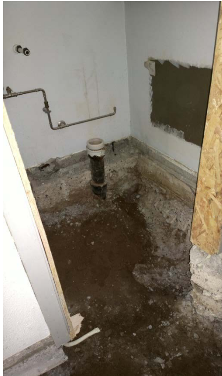
Foto 24 Udgravning for nyt terrændækning. Græsvangen sep. 2015
