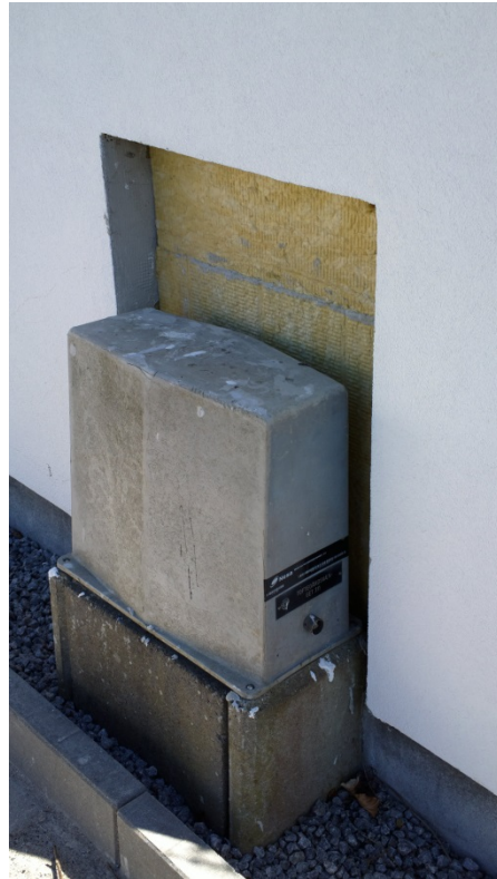
Foto 55 Der er udført udvendig facadeisolering, dog har det været økonomisk urealistisk at flytte elinstallasjon for at få plads til isoleringen. Toftegaardsvænget, Asminderød
