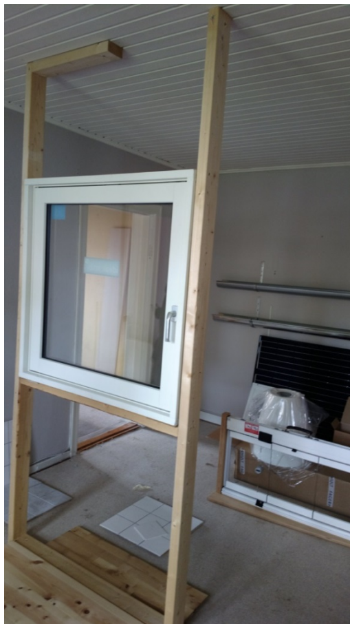
Foto 4 Mock-up af vinduesløsning i prøvelejlighed hvor også køkkenelementer kunne seses. Ulvefodsvej, København
