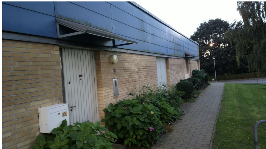
Foto 31 Hovedindgangspartier, der er ikke planlagt efterisolering af disse facader hvorimod de lette facader imod havesiden efterisoleres. Stenhøjgaardsvej
