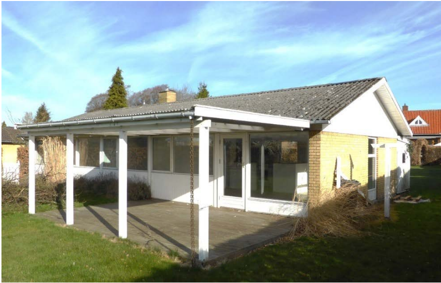
Foto 53 Parti fra Toftegaardsvænge. Kilde: Entreprenørens hjemmeside, feb. 2016
