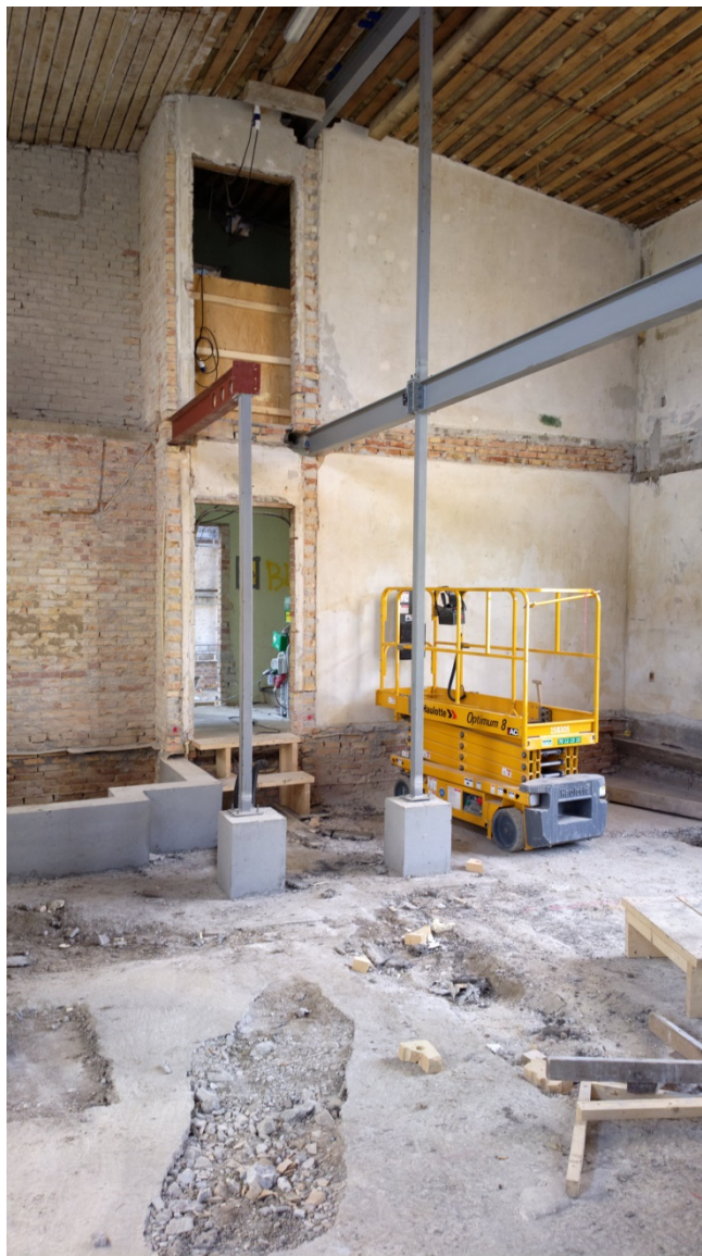
Foto 14 Meget omfattende renovering hvor alene bygningsskallen (tag og ydervægge) står tilbage. Der opbygges ny etageadskillelse med stålkonstruktioner, som bæres af nye fundamenter (Baldersbo, Ballerup)
