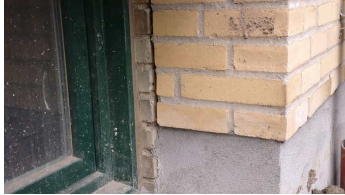
Foto 48 Den nye isolerede skalmur uden på den gamle gulstensfacade. Ulvehedsvej, København
