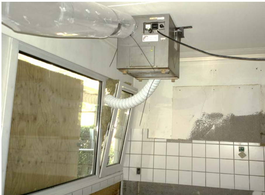
Foto 3 Tørring af og affugtning i hus med skimmel som er underrenovering. Græsvangen, Aarhus
