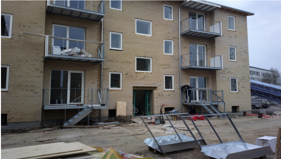
Foto 49 De renoverede facader med altaner. Ulvefodsvej, København
