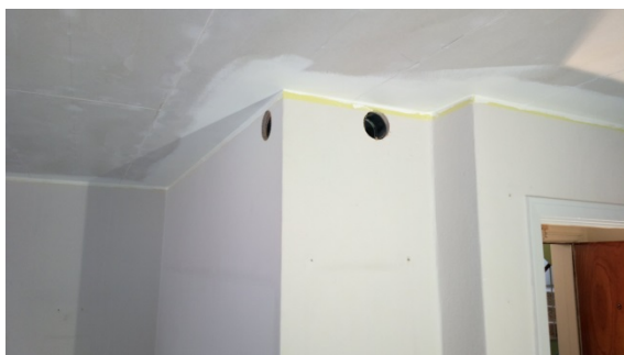
Foto 19 Ventilationsrør fremføres i kommende nedhængt loft (Jyllandsgade)
