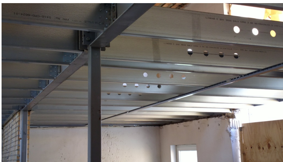
Foto 16 Nyt etagedæk af stål (Baldersbo, Ballerup)
