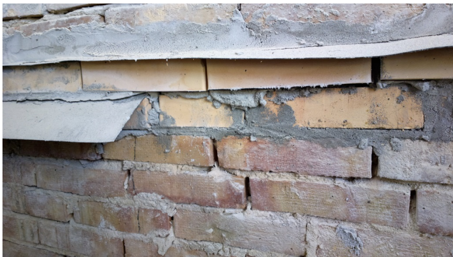
Foto 15 Det har, nogle steder været nødvendige med nye skift over soklen da fugtmembranen mod soklen manglede (Baldersbo, Ballerup)
