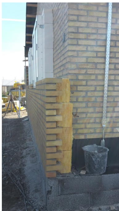
Foto 41 Etablering af ny muret facade med isolering. Peter Hansensvej, Fåborg. Foto: Turid Øien
