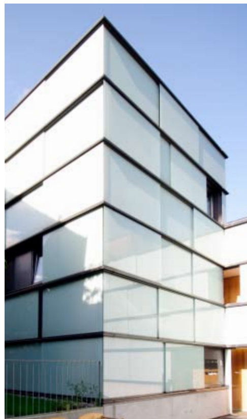
Let og højisoleret træfacade med glas som regnskærm Sebastianstrasse, Dornbirn Baumschlager & Eberle, 2002
