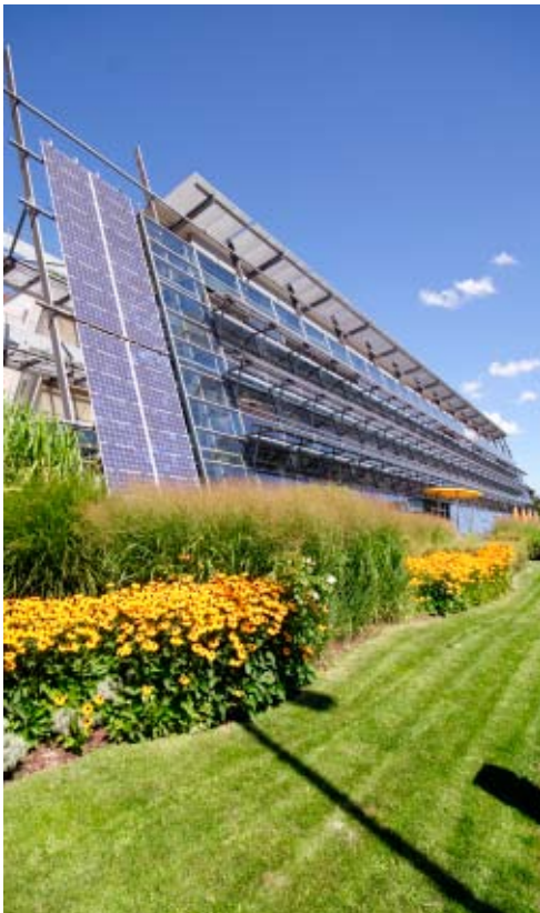
Facadeintegreret elproduktion med solceller Solar-Fabrik, Freiburg Rolf & Hotz, 1998
