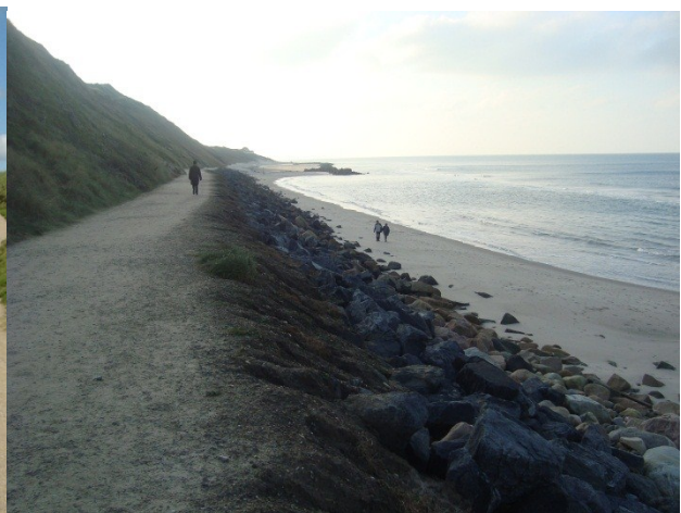
Sti og skråningsbeskyttelse med en smal forstrand (eget foto november 2011)
