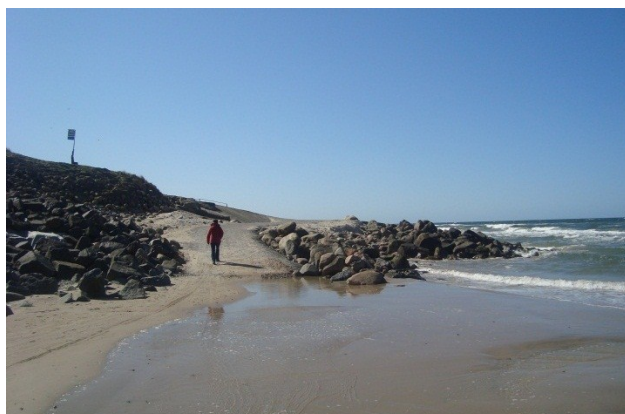
Nedkørslen set fra nord (eget foto april 2012)
