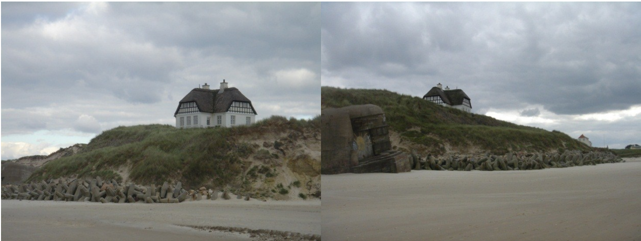
Punktvis kystsikring ved Løkken med betonblokke ("tetrapoder") (egne fotos sept. 2008)
