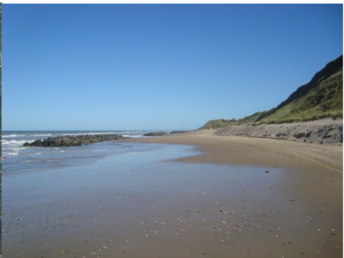
Afslutning af anlægget mod syd (eget foto september 2009)
