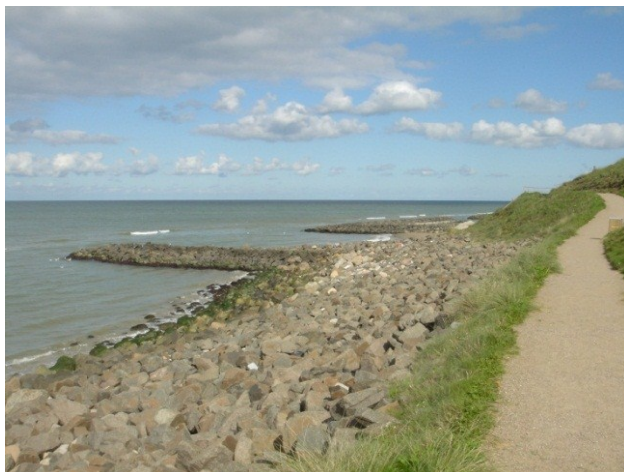
Sti og kystsikring med høfder og skråningsbeskyttelse uden forstrand (eget foto sept. 2008)
