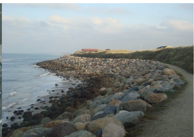
Skræntsikring med granitblokke (eget foto november 2011)
