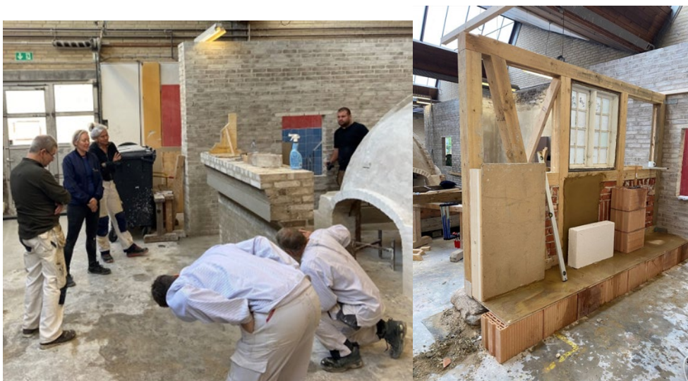
FIGUR 44. Fysiske 1:1 mock-up af studenteropgaver på EUC Nord. Til venstre ses dialog om mock-up af gesims med trukket puds, og til højre ses mock-up af efterisolering af bindingsværk. Kilde [Kilde 6.4 Modul V, side 3 og 4]
