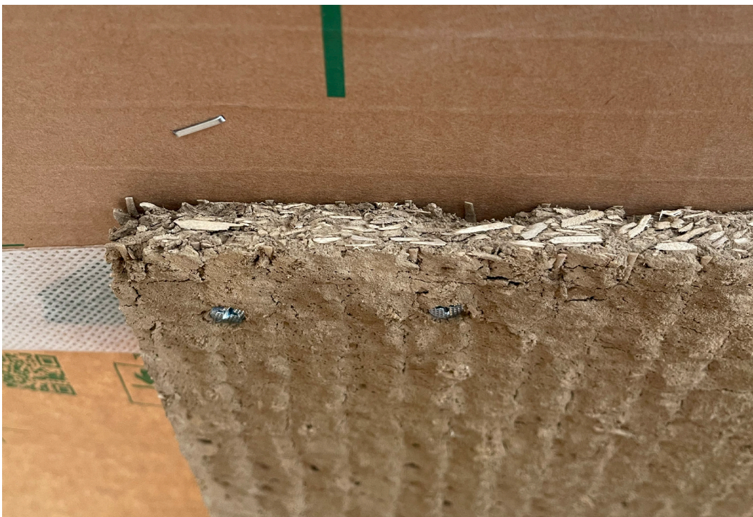
↑ Øverst: Tagkonstruktion under opbygning Foto: Hedeskov
