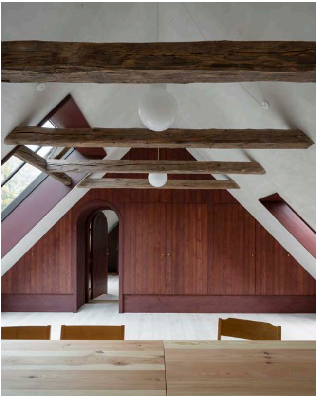
↑ Øverst: Inventarvæg i mødelokalet på 1. sal med fronter af genbrugte gulvbrædder. Behandlet med indfarvet linolie
