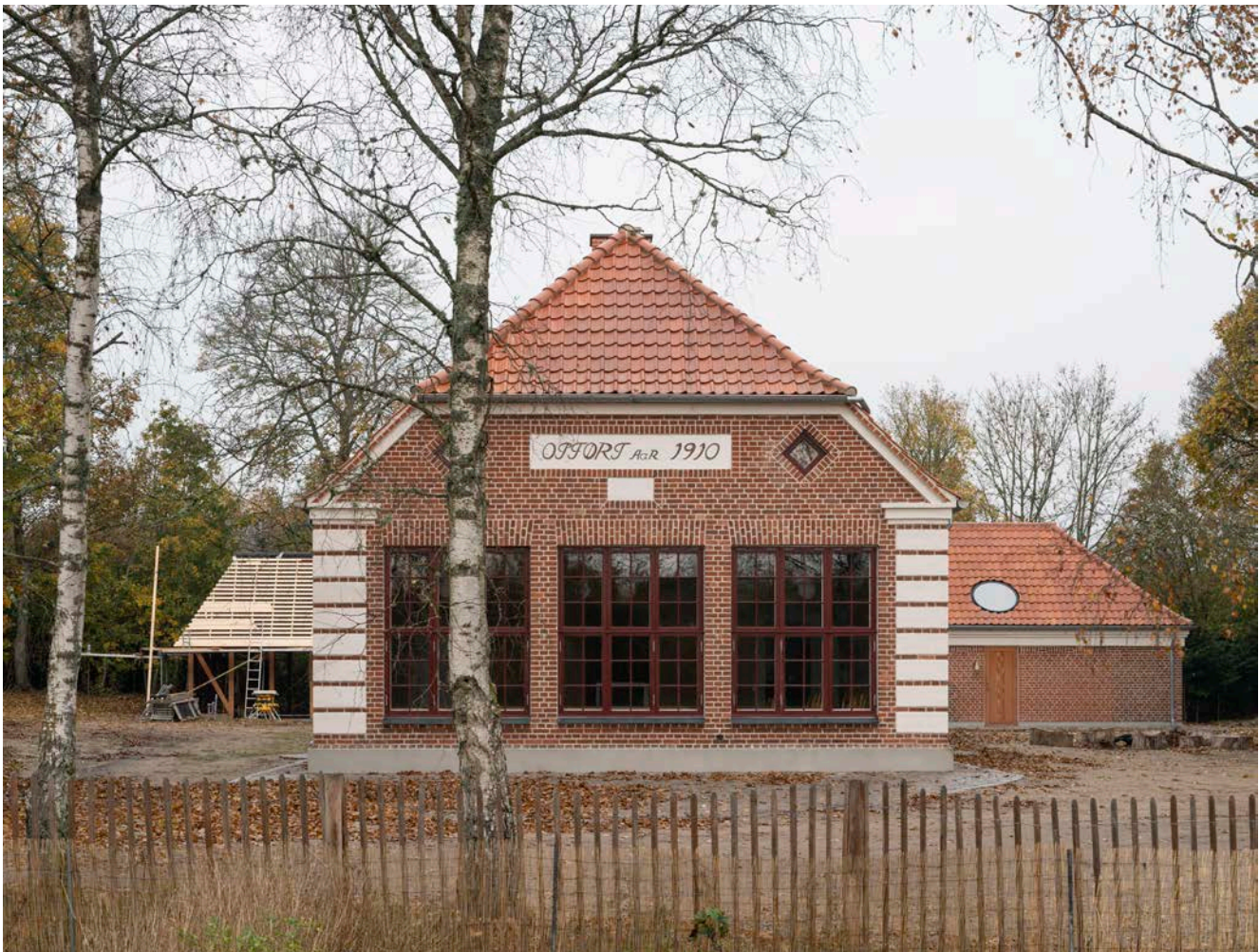
↑ Øverst: Hovedbygningen under renovering Foto: Hampus Berndtson
