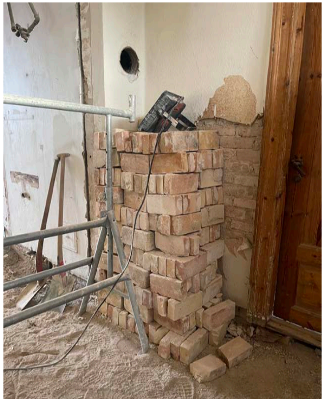
↑ Nedtagne mursten fra eksisterende bygning, rensed og opbevaret til skillevægge andre steder i bygningen
