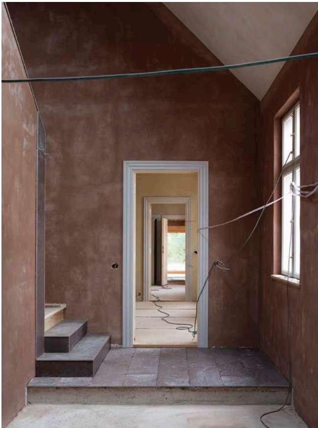
↑ Hovedbygningen under renovering. Terrændæk i kalkbeton
