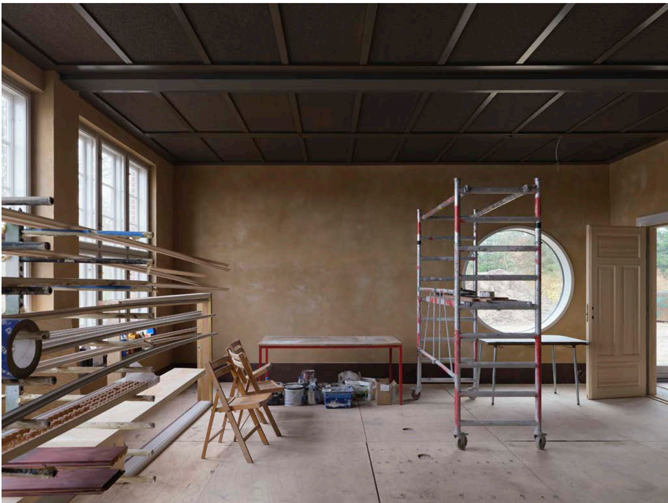
↑ Billede af skolestuen/formidlingsrum under udførelse
