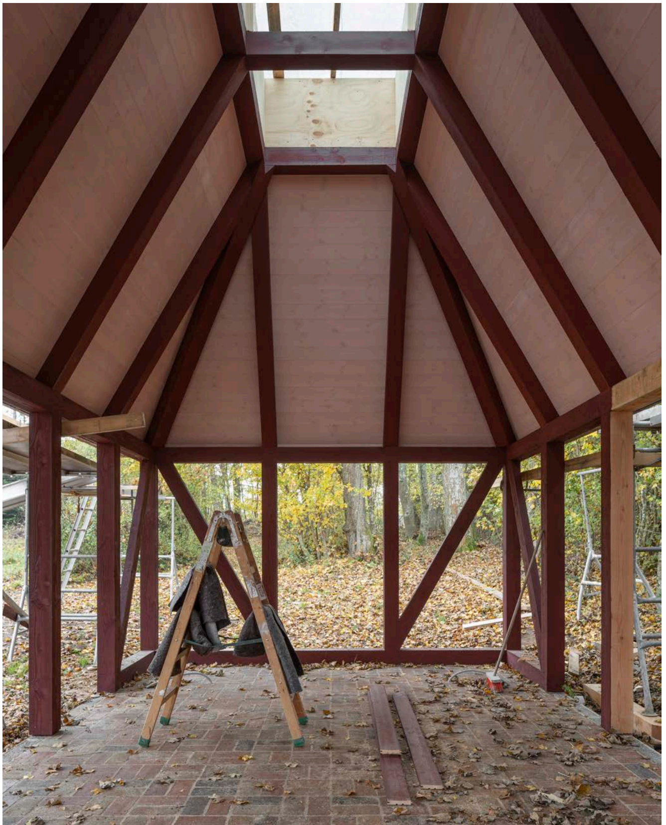
↑ Havepavilon under opførelse
