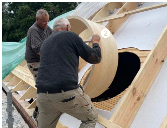
↑ Isætning af den runde vindueslysning i taget
