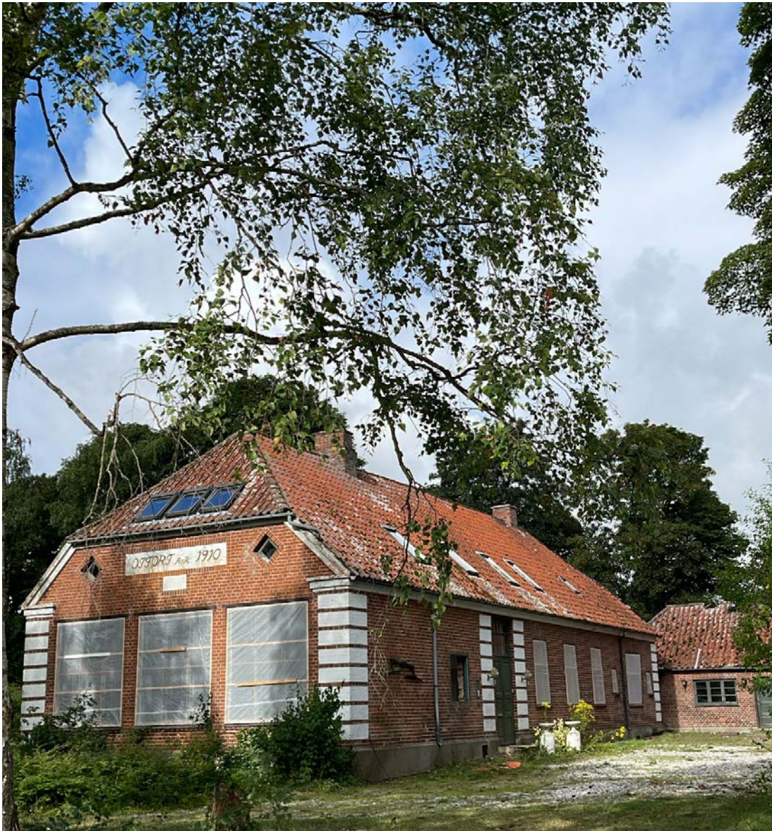
↑ Bygningen under renovering
