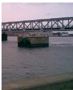
"Gl.bropille" uden platform og gangbro. Jernbanebroen bagved.
