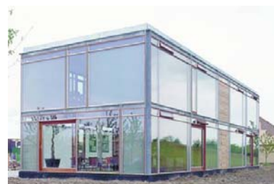
Det højisolerede glashus(1999) . SBI-rapport 317
