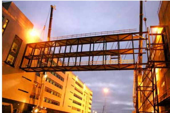
Gangbro mellem bygningerne ved dens montage.
