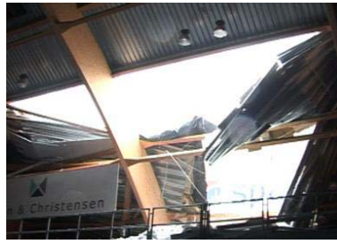
Tagkonstruktionens kollaps
