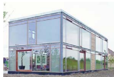
Det højisolerede glashus(1999) . SBI-rapport 317
