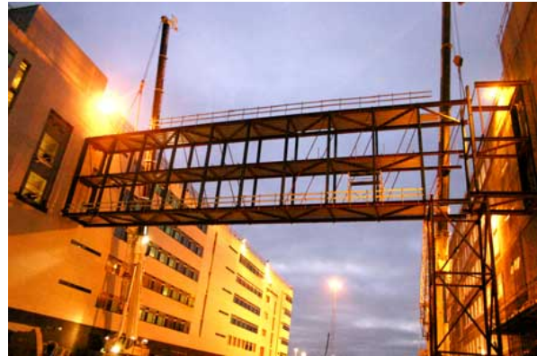
Gangbro mellem bygningerne ved dens montage.
