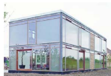
Det højisolerede glashus(1999) . SBI-rapport 317
