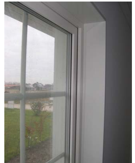
Vinduesparti i ydervæg.
